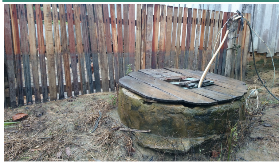
Foto 12: Poço de abastecimento em residências da vila Tabajara
