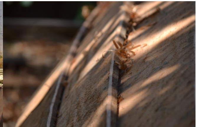
Foto 05. Detalhe da sobreposição de tábuas em processo de preparação.
