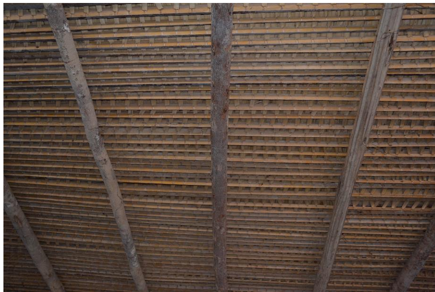
Foto 16. Trançados usados para cobertura das casas feito a partir da folha de palmeiras.
