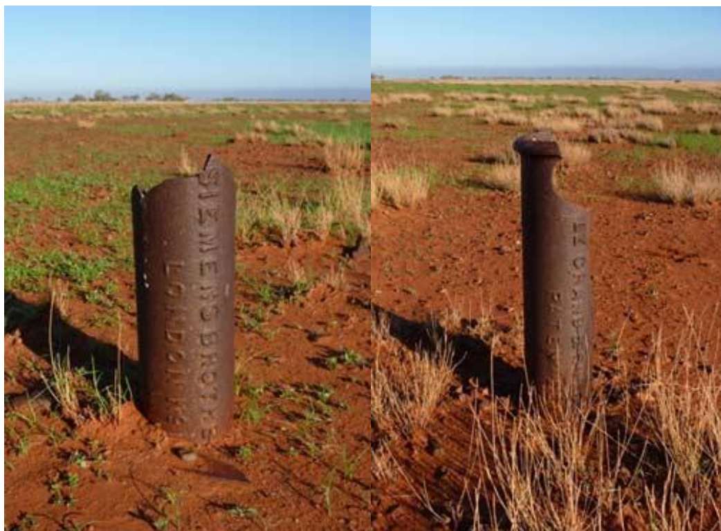
Fotos 101 e 102: Postes de ferro fundido da Siemens Brothers, encontrados no extremo noroeste da Austrália, da linha Perth-Roeburne (foto de Milan Kovac s/d atlantic-cable.com).
