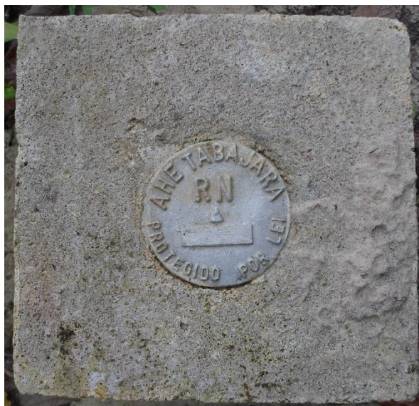
Foto 1: Marco de concreto no local onde será o eixo da barragem.
