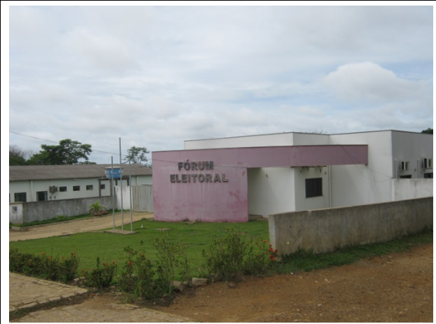
Foto 08: Sede do Fórum Eleitoral de Machadinho D'Oeste.
