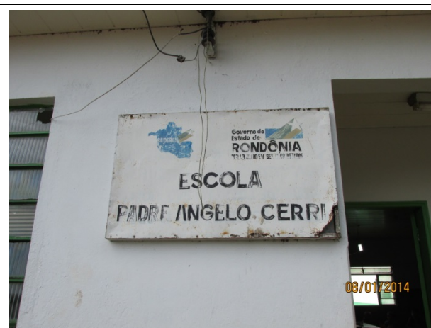
Foto 24: Escola Municipal de Ensino Fundamental Padre Angelo Cerri, localizada no núcleo da Vila Tabajara.
