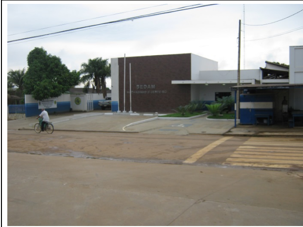
Foto 07: Sede da Secretaria do Estado de Desenvolvimento Ambiental (SEDAM), de Machadinho D'Oeste.
