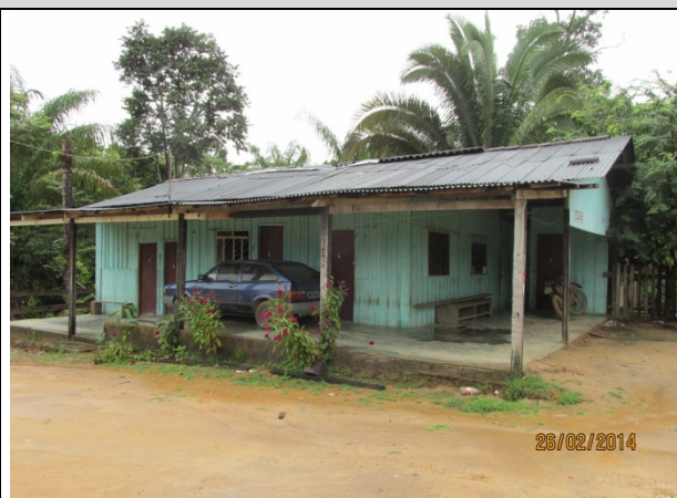
Foto 76: Domicílio de moradores do núcleo de Dois de Novembro.
