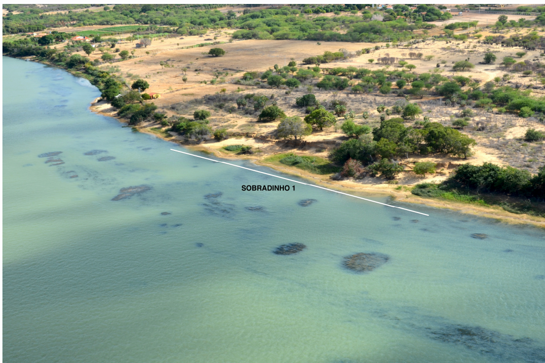
Figura 6.13 - Ponto de Monitoramento Sobradinho 1. Para localização ver figura 6.12.
