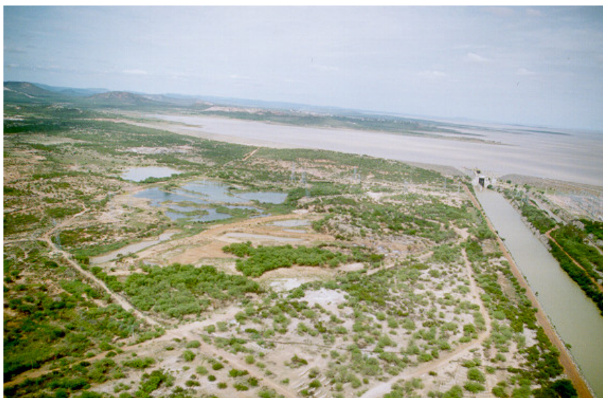
Foto 24: Detalhe de área localizada a jusante da barragem principal do reservatório, desprovida de vegetação e com instalação de processos erosivos superficiais
