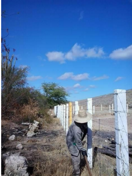
Foto 1 - Manutenção da cerca, aceiro e limpeza no entorno da área 02.
