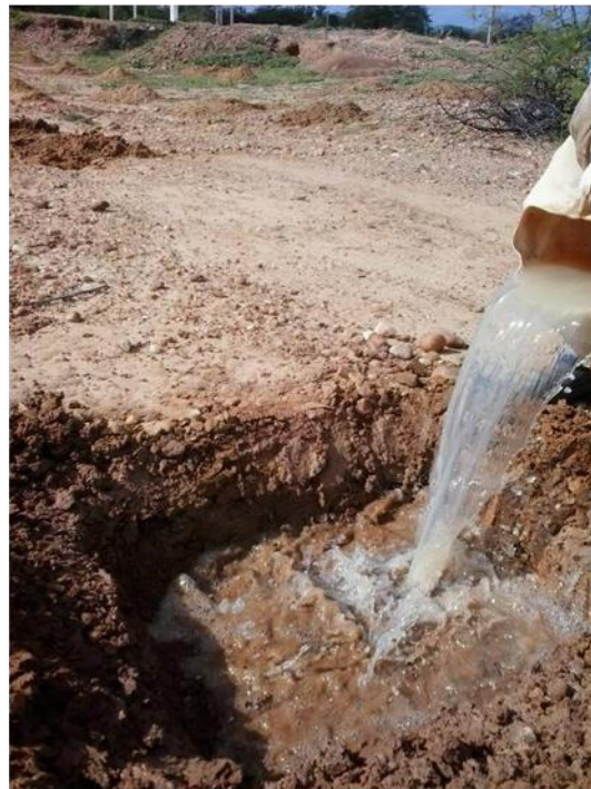
Foto 4 - Uso de água para facilitar a escavação das covas com dimensões de 0,4 x 0,4 x 0,4 m na área A.
