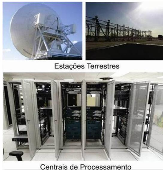
**Figura 5 - Estações terrestres e centrais de processamento utilizadas para correção das coordenadas coletadas no campo. Fonte: Modificado - Manual Técnico Land-Pak NavCom Technology.**
