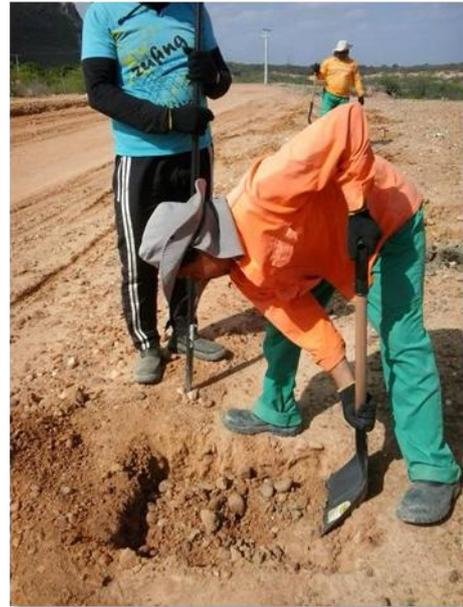
**Foto 20 - Detalhe das covas com dimensões de 0,4 x 0,4 x 0,4 m na área A.**
