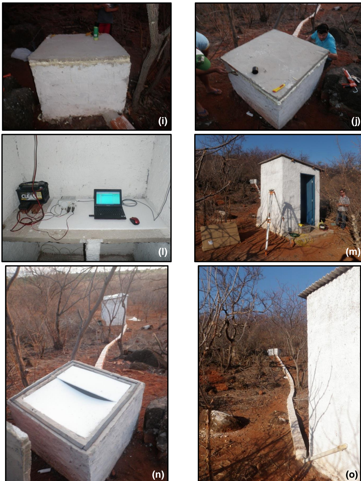
Figura 05: Mostra o passo a passo da instalação da estação sismográfica SOB 02, sendo: (A) a (D) Instalação do painel solar e antena GPS Trimble sobre o teto do abrigo da estação; (E) a (G) Instalação do sismômetro dentro do abrigo, assim como o posicionamento e orientação em relação ao norte do sensor com bússola de precisão; (H) a (J) Acondicionamento e isolamento térmico do abrigo do sensor do sismógrafo; (L) Vista do interior do abrigo com os equipamentos instalados e em funcionamento; (M) a (O) Vista lateral da estação sismográfica da UHE de Sobradinho - SOB 02, sendo rastreada por GPS geodésico de precisão.
