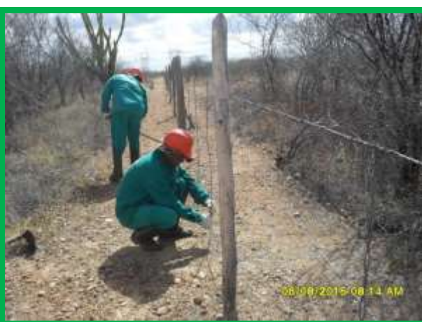
Fotos 3 e 4 – Ajustamento de fios e balancins da cerca. Antônio Briene.
