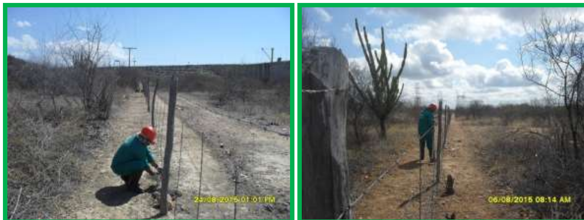
Fotos 5 e 6 – Ajustamento de fios e balancins da cerca. Antônio Briene.
