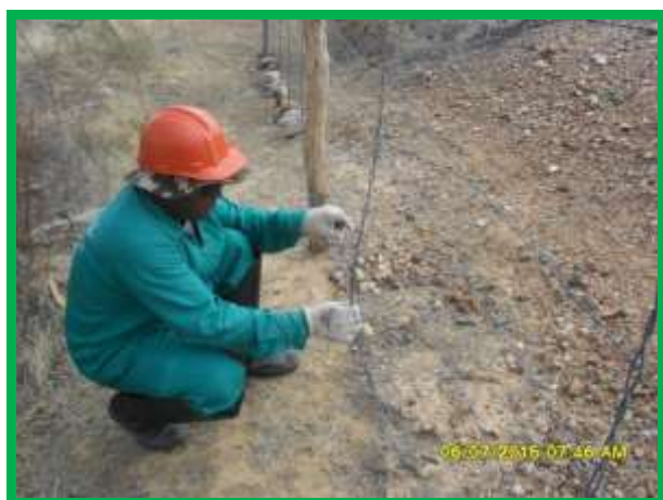
Fotos 3 e 4 – Ajustamento de fios e balancins da cerca. Antônio Briene.
