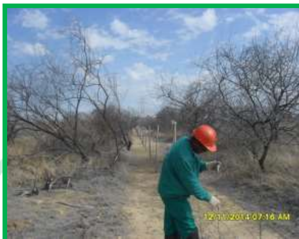
Fotos 3 e 4 – Ajustamento de fios e balancins da cerca. Antônio Briene.
