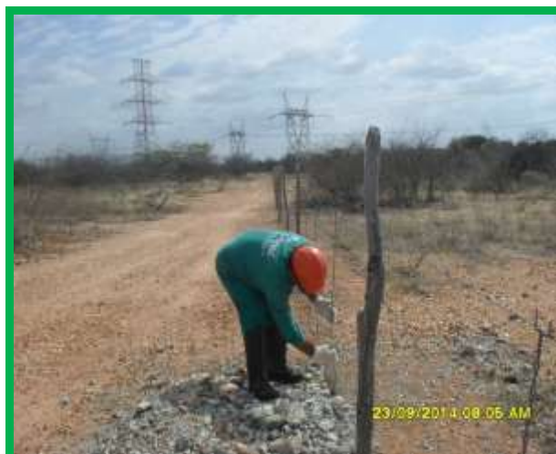
Fotos 1 e 2 – Ajustamento de fios e balancins da cerca. Antônio Briene.
