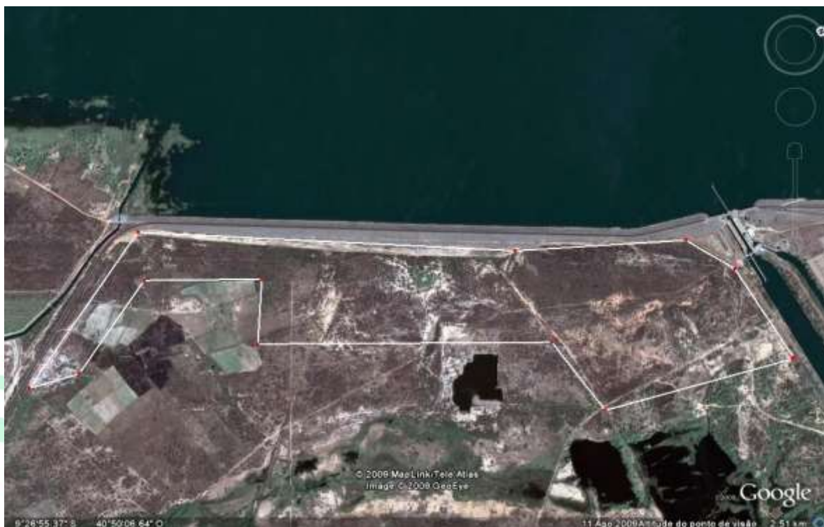
Figura 1 – Demarcação das áreas que estão sendo recuperadas.
