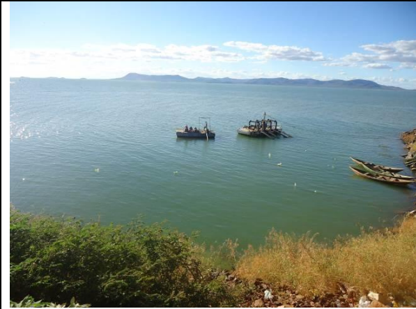
Figura 15 - Captação de água bruta reservatório Sobradinho.
