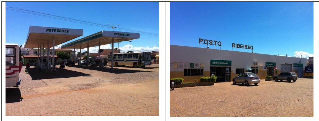
Figura 54 – Posto Ribeirão – pátio de abastecimento inadequado – Sento Sé – Ponto 77.
