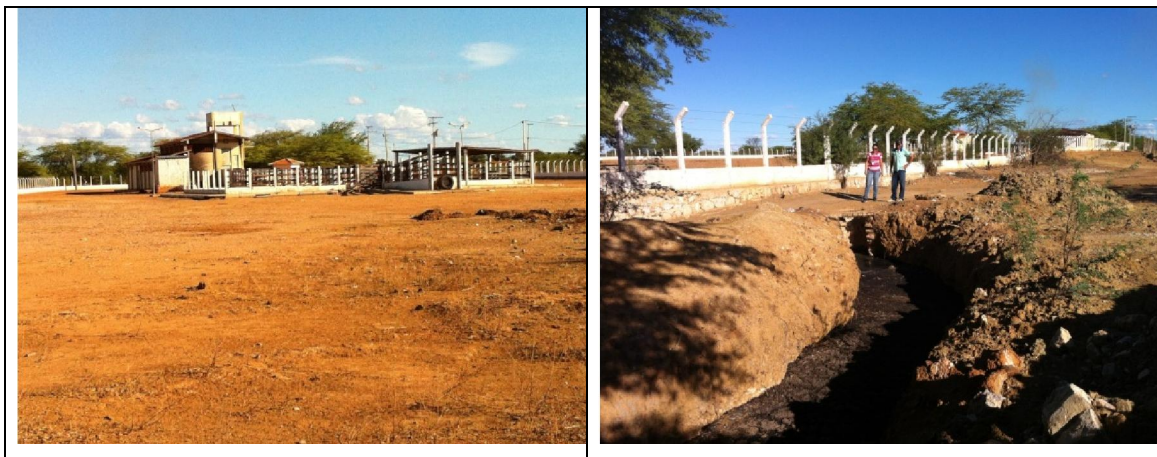
Figura 31 – a) Visão geral do Matadouro; b) Vala aberta do lançamento de esgoto com disposição direta no solo.
