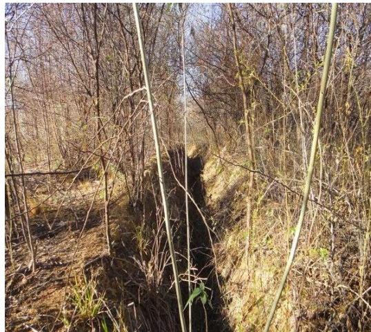
Figura 47 - Ponto 09 - Vala de drenagem do excedente da irrigação direcionada ao reservatório. Faz Caetano / Sobradinho
