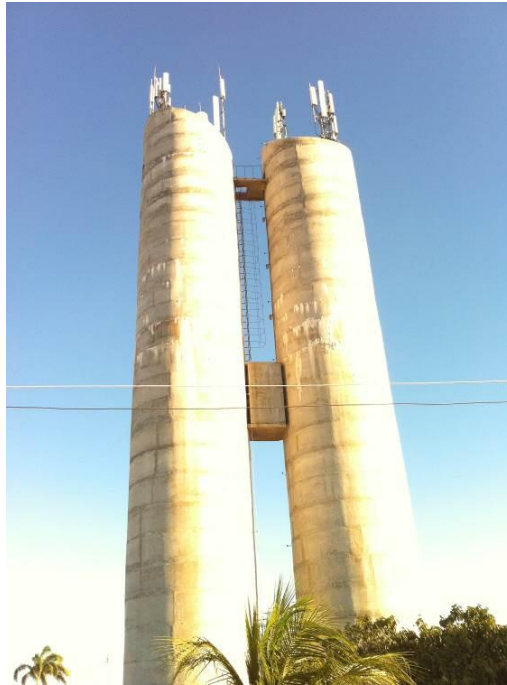
Figura 8 - Elevatória de água tratada
