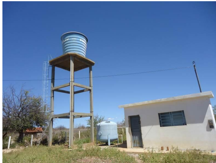
Figura 12 - Tratamento e abastecimento de água da Comunidade São Gonçalo - Sobradinho/Ba.
