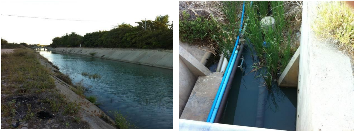
Figura 5 - Captação de água bruta no canal Serra da Batateira, Sobradinho/Ba.
