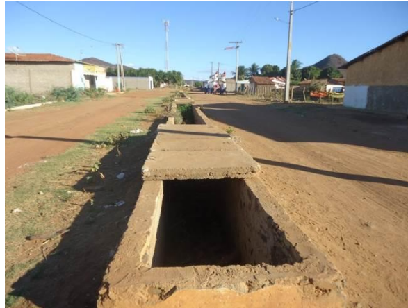
Figura 84 – Canal de drenagem de água pluvial – Sento Se
