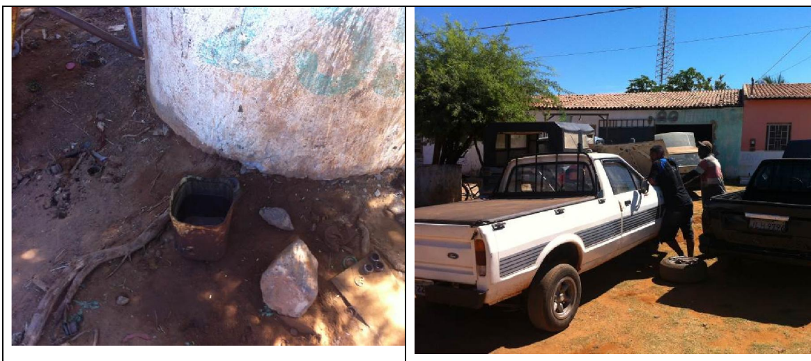
Figura 58 - Mecânica do Gilmar - pátio de trabalho inadequado, Ponto 75 – Sede de Sento Se
