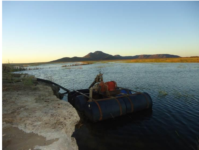
Figura 20 - Captação de água do Reservatório Sobradinho - Piçarrão -Sento Sé/Ba -
