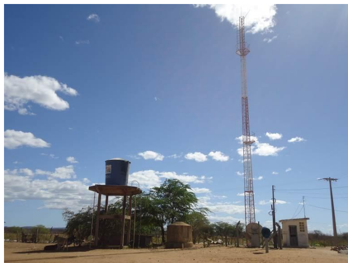
Figura 13 - Elevatória de distribuição de Algodões - Sobradinho/Ba
