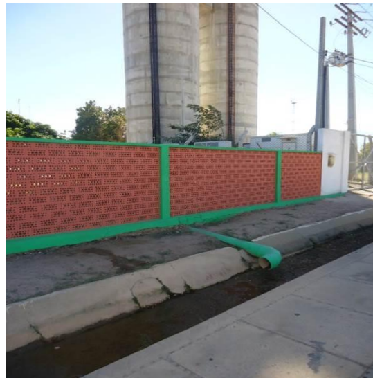
Figura 83 - Lançamento da lavagem dos filtros da ETA de Sobradinho, canal de drenagem superficial de águas pluviais.
