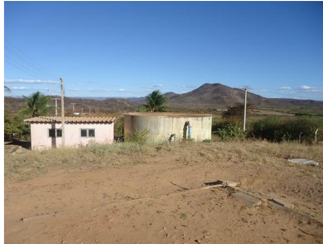
Figura 17 - Reservatório apoiado – SAAE –Sento Sé.
