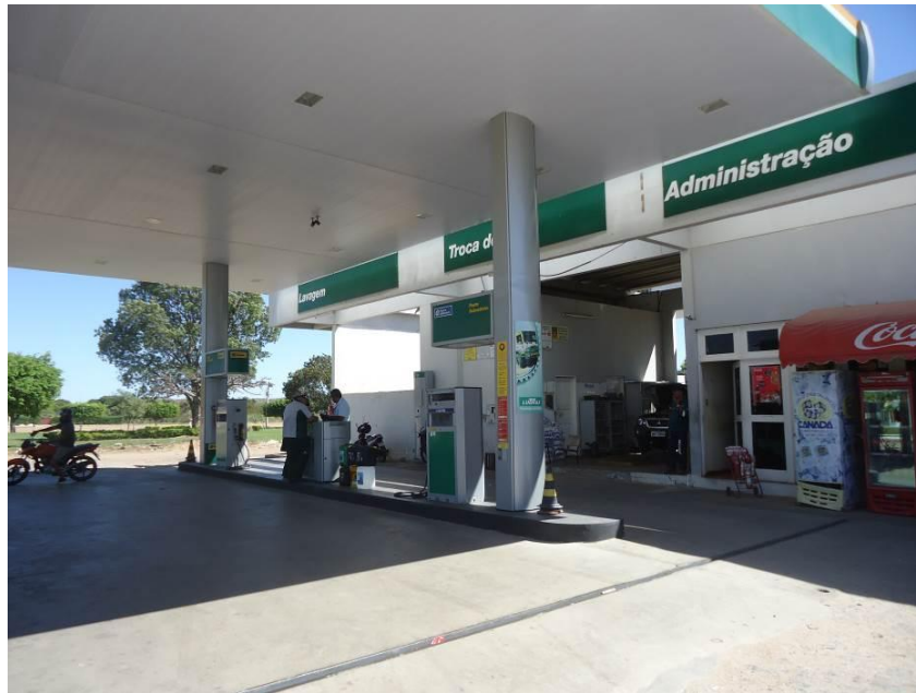
Figura 32 - Posto, detalhe da canaleta que coleta os resíduos a uma caixa separadora de água e óleo.
