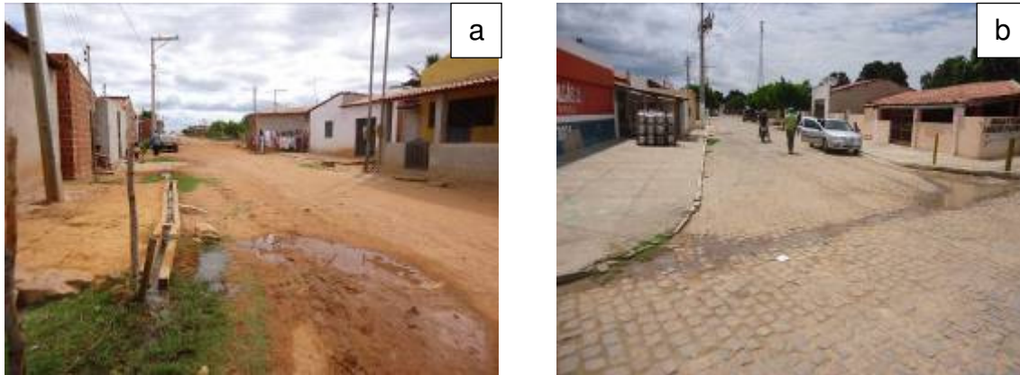
Figura 13 - a) Esgoto a céu aberto; b) Água cinza a céu aberto.
