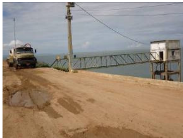
Figura 18 - Detalhe da adutora de água bruta, travessia para tomada de água.
