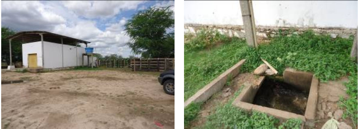
Figura 82 – a) Matadouro municipal; b) Destino final do efluente do matadouro.
