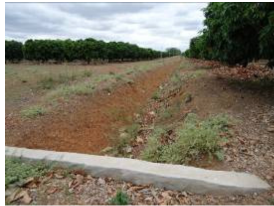
Figura 63 – a) Drenagem coletora do dreno subterrâneo na fazenda Santa Maria b) Dreno superficial na fazenda Eduardo JN .
