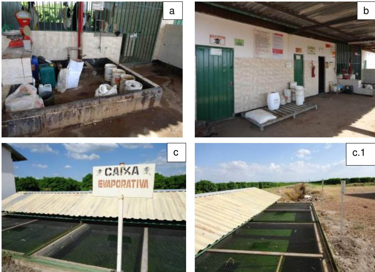
Figura 111 – a) Área da tríplice lavagem das embalagens de agrotóxico. B) Local de armazenamento das embalagens; c e c.1) Caixa evaporativa, destino final dos efluentes da tríplice lavagem na Fazenda Fortaleza- Casa Nova-Ba.
