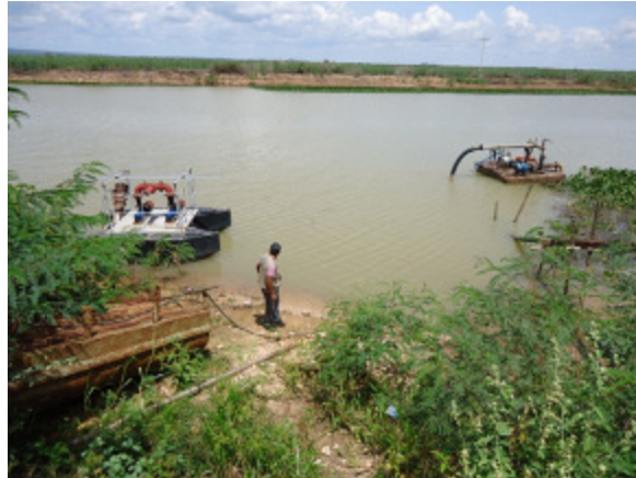
Figura 28 - Captação de água bruta reservatório Sobradinho.
