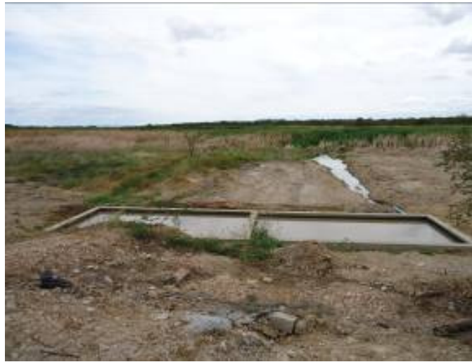
Figura 78 - Corpo Receptor do efluente gerado pela ETE
