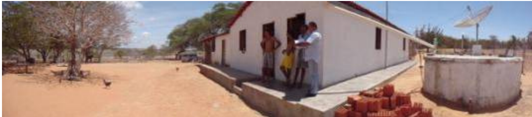
Figura 11 - Cisterna de captação e armazenamento de água da chuva.
