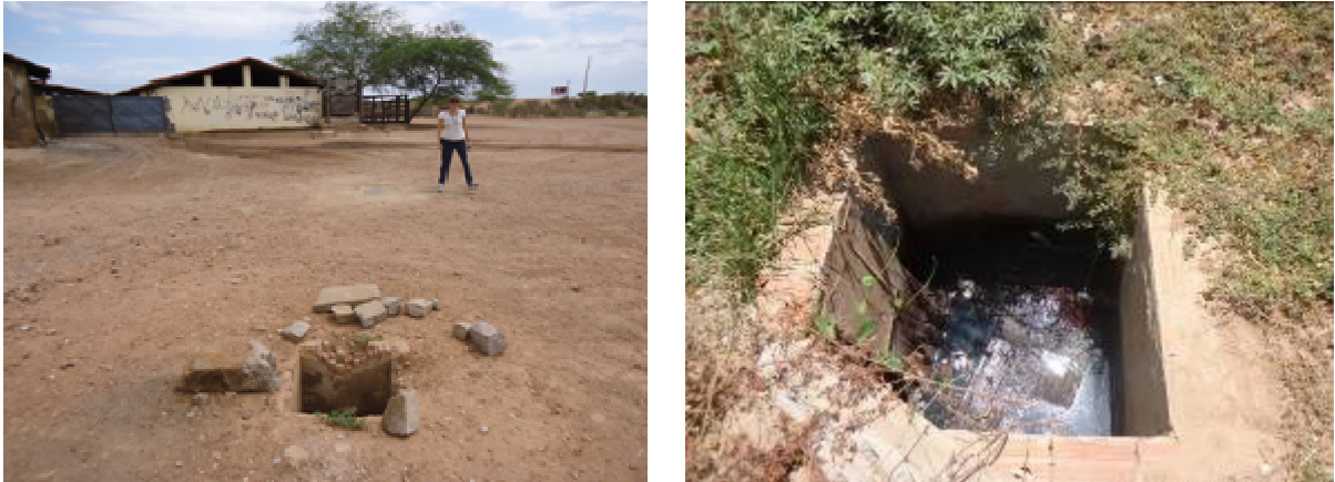
Figura 37 – a) Matadouro ao fundo, detalhe da caixa de esgoto; b) Caixa de esgoto com disposição direto no solo.
