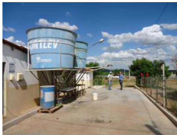
Figura 110 - Área da tríplice lavagem das embalagens de agrotóxico da Fazenda Agrobás, Casa Nova-Ba.
