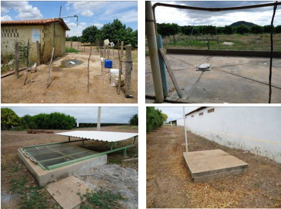
Figura 76 - a) Local de preparação da calda irregular com infiltrações. b) Caixa receptora de efluentes da casa de calda; c) Tanque de evaporação; d) Fossa séptica.
