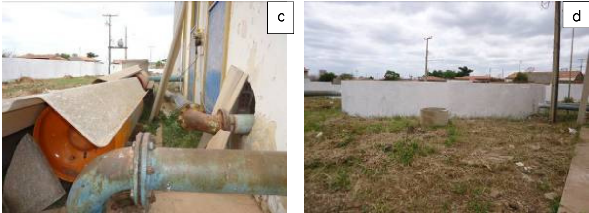
Figura 5 - a) ETA; b) Detalhe dos floculadores e decantadores; c) Armazenamento do cilindro de cloro; d) Tanque de contato e reservatório de água tratada.
