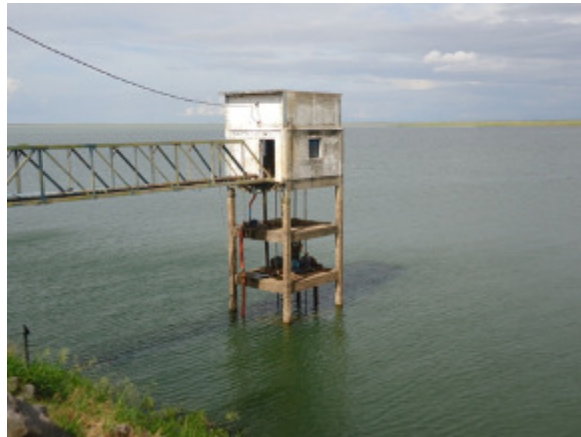
Figura 17 - Captação de água bruta reservatório Sobradinho, por Tomada d'Água.
