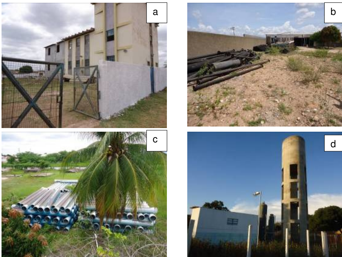
Figura 107 - a) Eta inacabada - Casa Nova; b) Materiais em ferro fundido abandonado ao tempo no pátio da Eta de Pilão Arcado; c) Tubulações ao tempo em pátio da Eta de Remanso; d) Pequenas estações de tratamento de água abandonadas em comunidades rurais.
