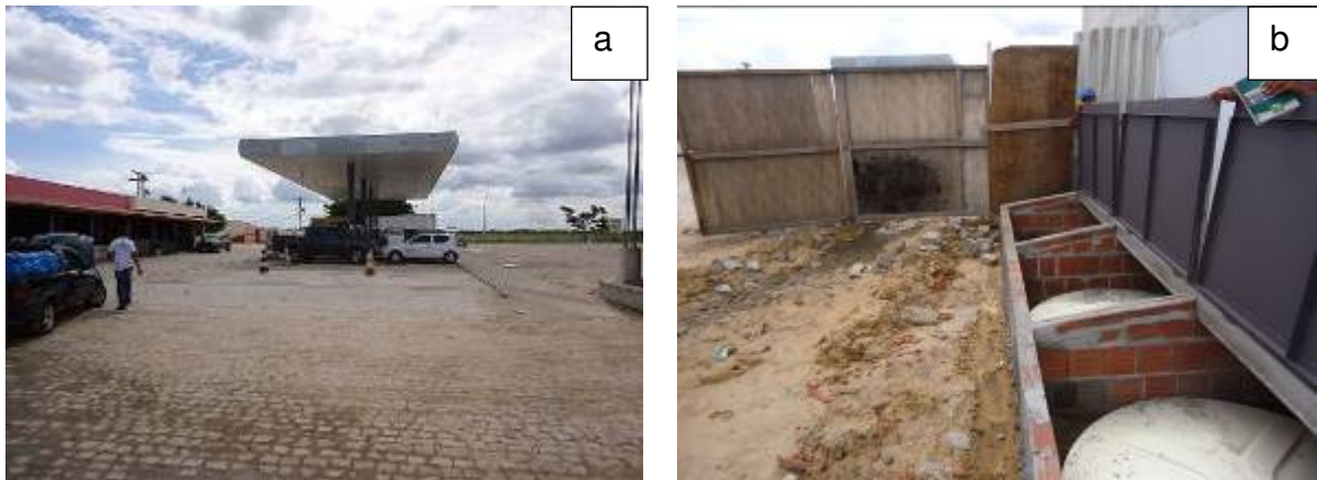
Figura 83 – a) Posto Brito; b) Detalhe da caixa separadora de água e óleo.
