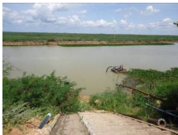
Figura 29 - Detalhe da adutora de água bruta a esquerda.
