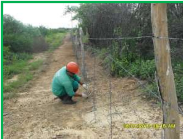
Fotos 1 e 2 – Ajustamento de fios e balancins da cerca. Antônio Briene.
