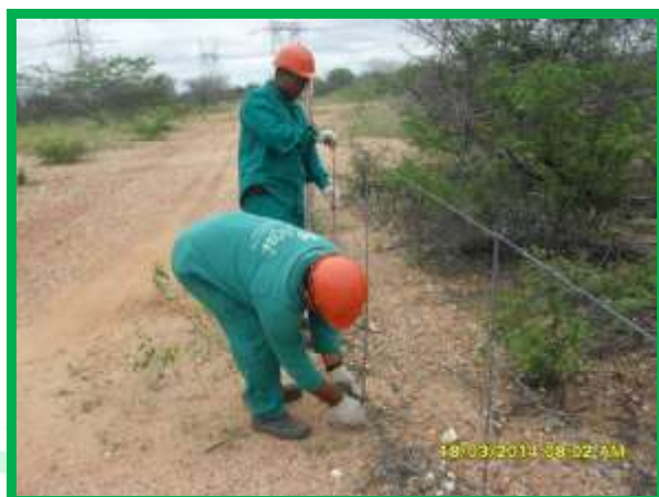
Fotos 1 e 2 – Ajustamento de fios e balancins da cerca. Antônio Briene.
