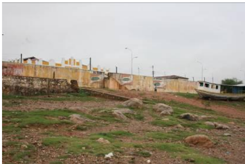
Foto 53: Vista da estrutura de base da antiga rampa do cais principal.
