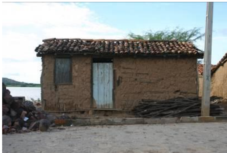
Foto 57: Algumas casas ainda preservam a tecnologia construtiva típica em taipa de mão.
