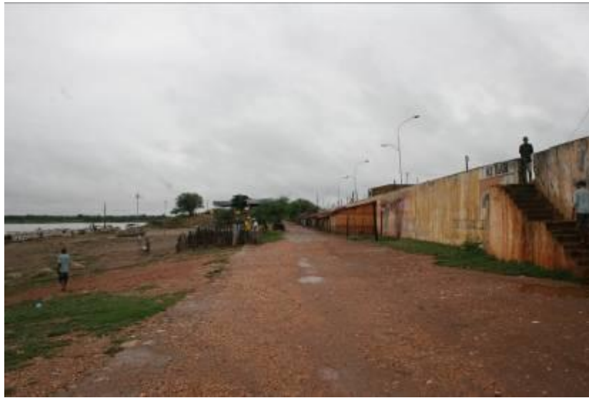
Foto 54: Processo de “favelização” da parte da muralha subutilizada de frente para o rio.
