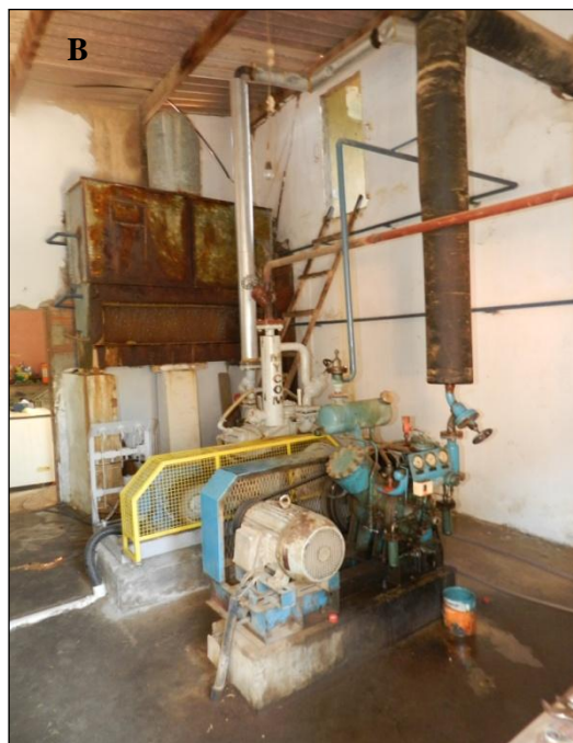
Foto 77: A - Câmara fria; e, B – Motores e condensador identificados nos frigoríficos de Xique-Xique (Rogério Cavalcante)
