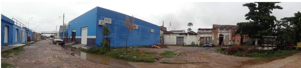
Foto 45: Instalações do porto. Fonte: Googleearth , 2013.
