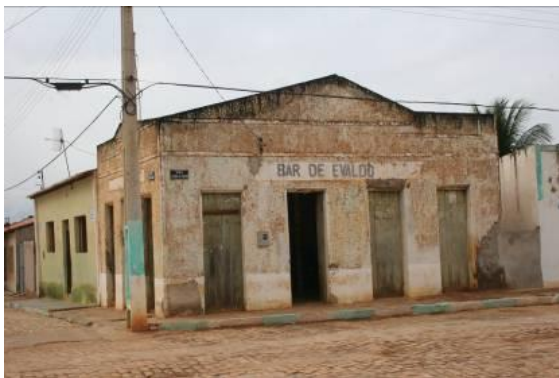
Foto 30: Casario / Comércio mais antigo: construções em "adobão" – blocos de barro com argamassa de barro (adobe). Casas mais antigas estão no núcleo urbano da igreja matriz.
