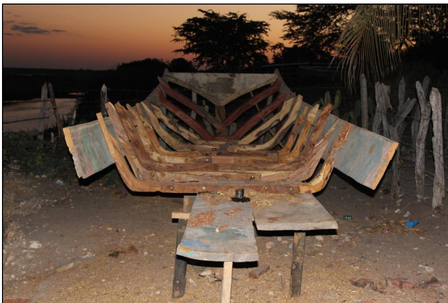
Foto 13: Estruturas de madeira chamadas de caverna, principal eixo de sustentação da embarcação. Comunidade de Passagem, Pilão Arcade (Imagem Sérgio Albuquerque)
