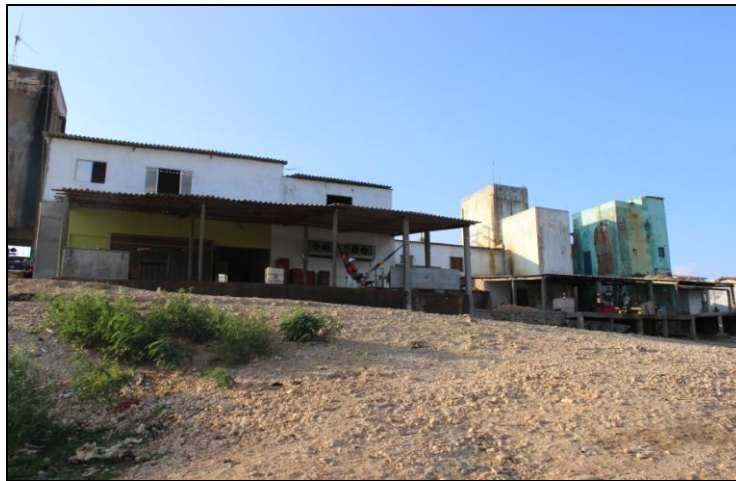
Foto 30 – Diversas estruturas como fábricas de gelo, câmaras frias e salas térmicas, localizadas na comunidade de Passagem, Pilão Arcado (Imagem Sérgio Albuquerque)
