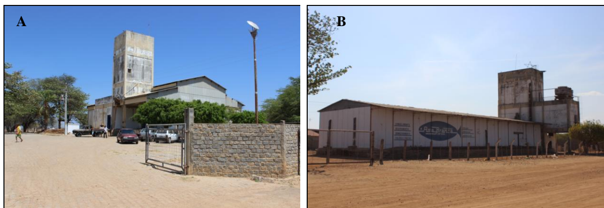
Foto 32: A – Terminal Pesqueira de Remanso; e, B - Frigorífico Asa Branca, estrutura encontra-se fechada (Imagem Sérgio Albuquerque)
