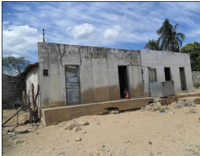
Foto 26: Duas das sete estruturas de recepção de pescado identificadas na comunidade de Cajuí em Sento Sé (Imagem Sérgio Albuquerque)
