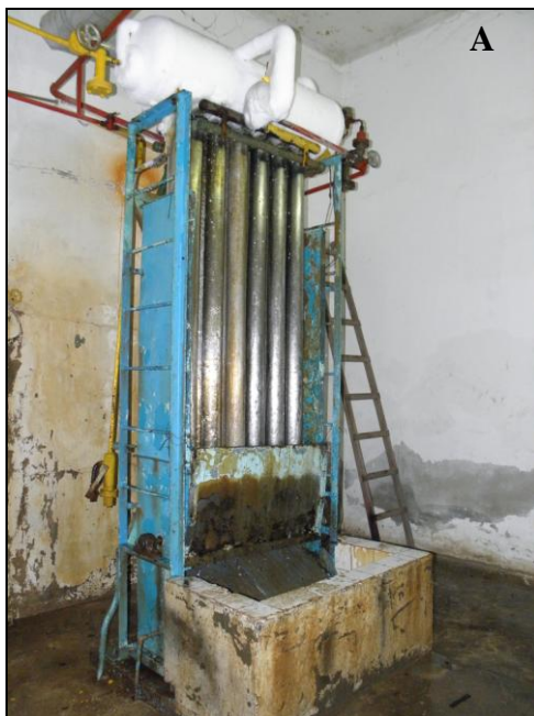
Foto 24: A – Condensador da fábrica de gelo; e, B – Sistema utilizado para a venda do gelo (Imagem Sérgio Albuquerque).
