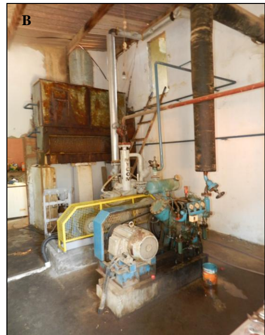
Foto 39: A - Câmara fria; e, B – Motores e condensador identificados nos frigoríficos de Xique-Xique (Imagem Rogério Cavalcante)
