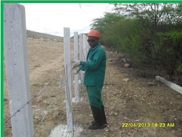
Fotos 19 e 20 – Esticamento de fios e ajuste de balancins. Antônio Briene.
