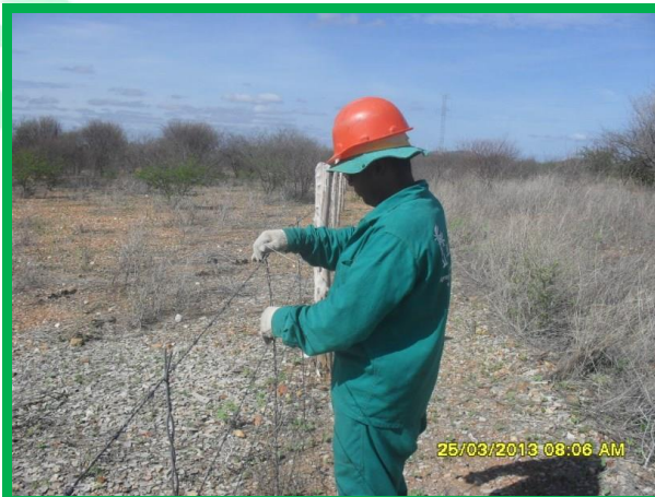
Fotos 17 e 18 – Esticamento de fios e ajuste de balancins. Antônio Briene.
