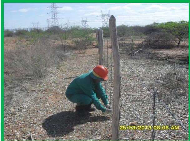
Fotos 17 e 18 – Esticamento de fios e ajuste de balancins. Antônio Briene.
