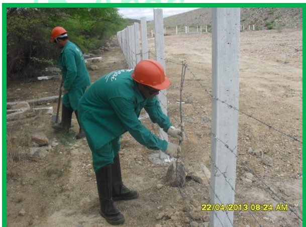
Fotos 19 e 20 – Esticamento de fios e ajuste de balancins. Antônio Briene.
