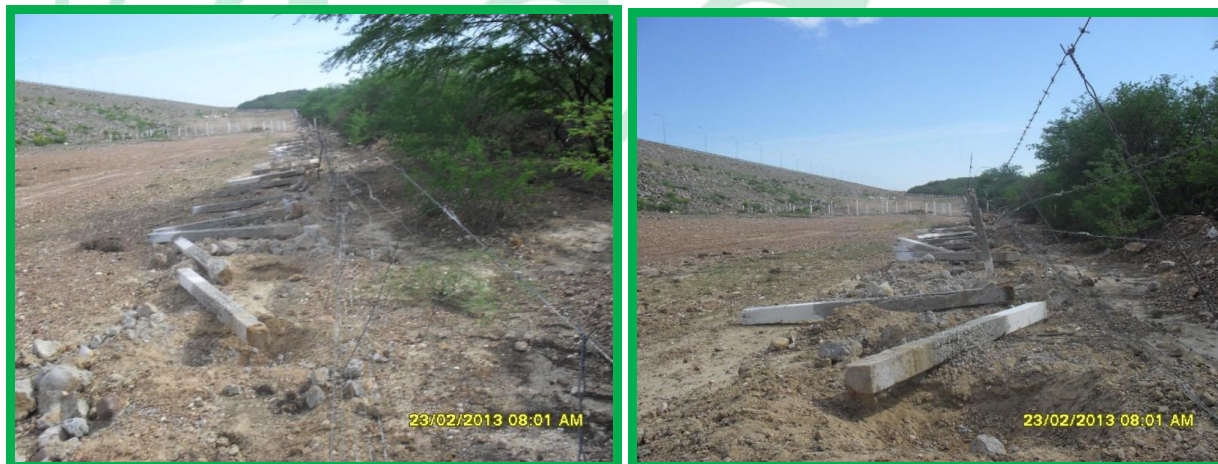
Fotos 1 e 2 – Cercas substituídas por outra empresa contratada. Antônio Briene.
