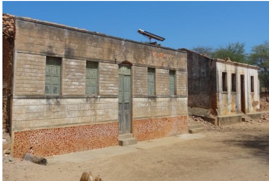
Foto 27: Habitação em alvenaria de tijolos de adobe, Pilão Velho, 2012.
