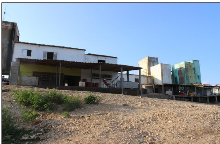
Foto 100: Diversas estruturas como fábricas de gelo, câmaras frias e salas térmicas, localizadas na comunidade de Passagem, Pilão Arcado (Imagem Sérgio Albuquerque)
