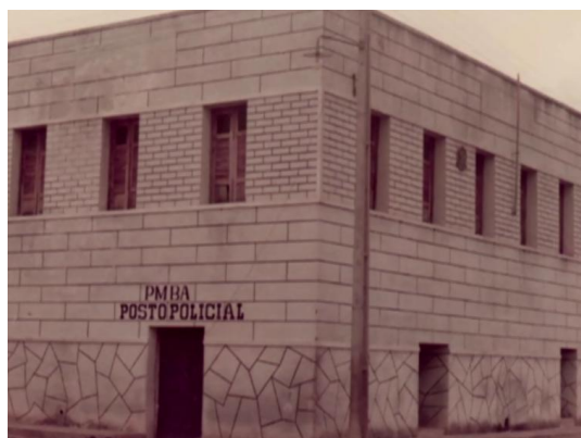
Foto 16: Antigo edifício da prefeitura e posto policial, s/d. Fonte: Ismar Júnior.
