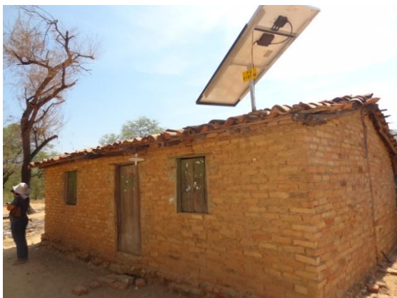
Foto 25: Habitação em alvenaria de tijolos de adobe, Pilão Velho, 2012.
