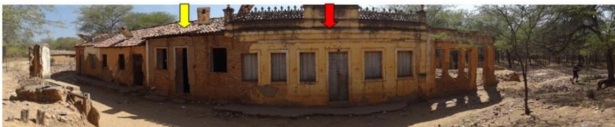
Foto 20: Ruínas da Rua do Meio, Pilão Velho, 2012. Fonte: Brasilencorp.
