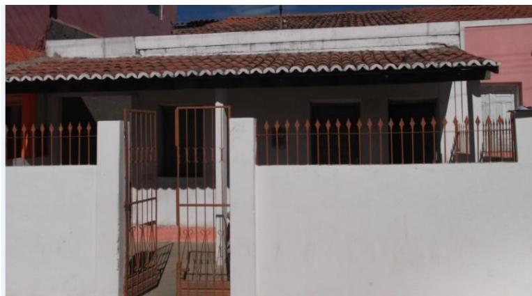
Foto 27: Modelo de habitação (descaracterizada) construída pela CHESF em Pau à Pique.
