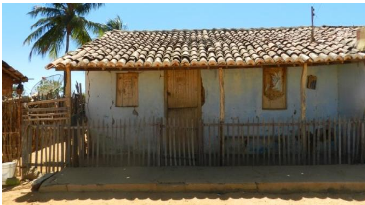
Foto 70: Casa em alvenaria na comunidade de Algodão Velho.
