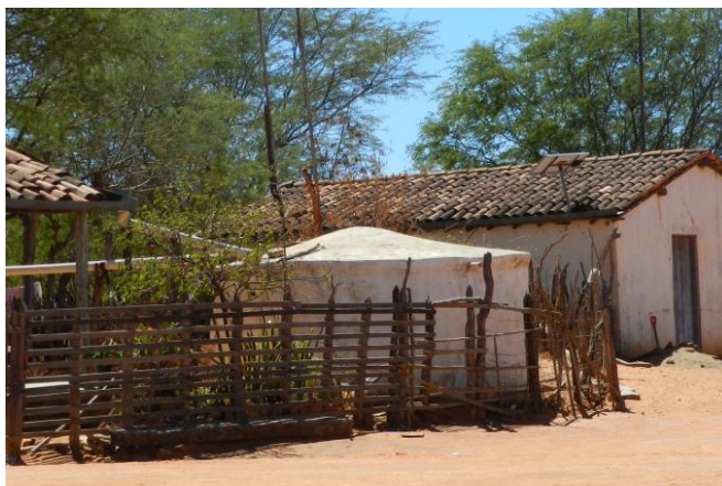
Foto 72: Casa de taipa na comunidade de Poço do Juá.
