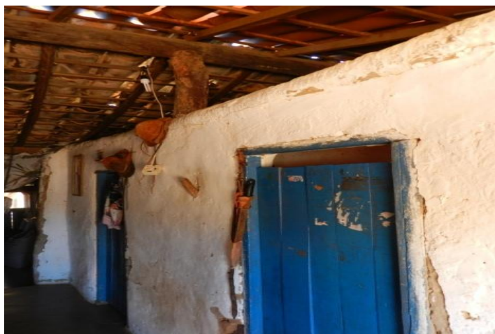
Foto 74: Interior de casa em taipa na comunidade Poço do Juá.
