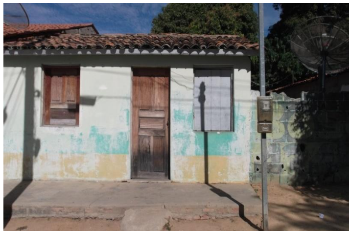
Foto 26: Modelo de habitação construída pela CHESF em Pau à Pique.
