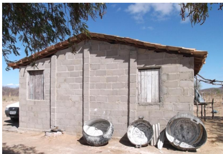
Foto 24: Casa de farinha em Pau à Pique.
