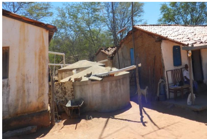
Foto 73: Casa de taipa na comunidade de Poço do Juá.
