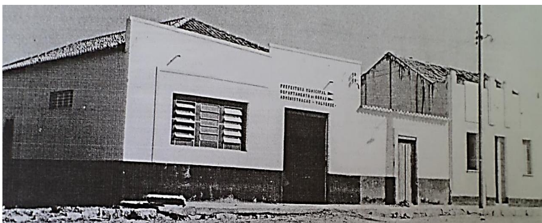
Foto 46: Antigo Edifício da Prefeitura, década de 1970.
