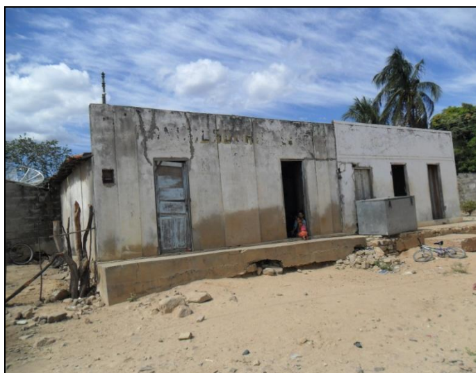
Foto 96 – Duas das sete estruturas de recepção de pescado identificadas em Cajuí
