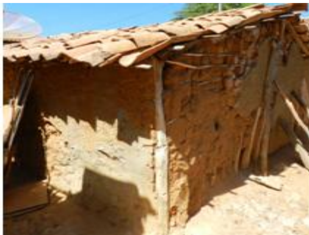
Foto 71: Casa de taipa manual na comunidade de Algodão Velho.
