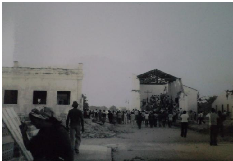
Foto 42: Igreja matriz de São José durante o período de relocação, 1976.
