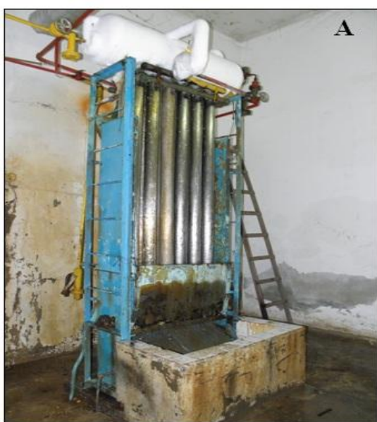
Foto 94 – A – Condensador da fábrica de gelo; B – Sistema utilizado para a venda do gelo.
