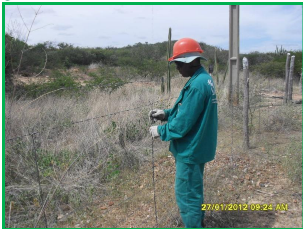
Fotos 3 e 4 – Recuperação de pontos danificados das cercas. Antônio Briene.
