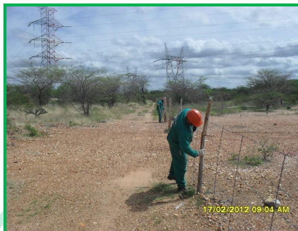
Fotos 5 e 6 – Recuperação de pontos danificados das cercas. Antônio Briene.
