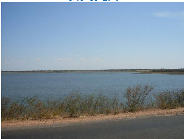
Foto 15 - Reservatório próximo a BR 235 no município de Casa Nova. Coordenadas 9° 10' 46" e 40° 59' 24".
