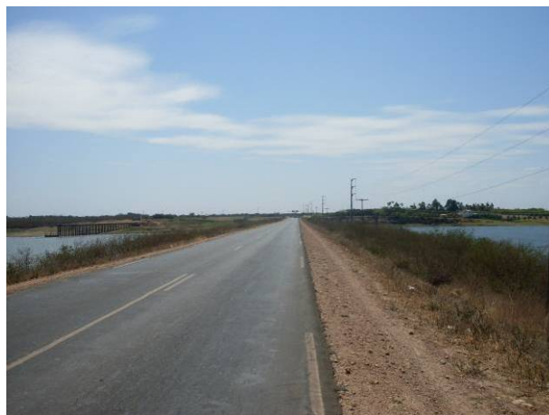
Foto 16 - BR 235 no município de Casa Nova. Coordenadas 9° 10' 46" e 40° 59' 24".
