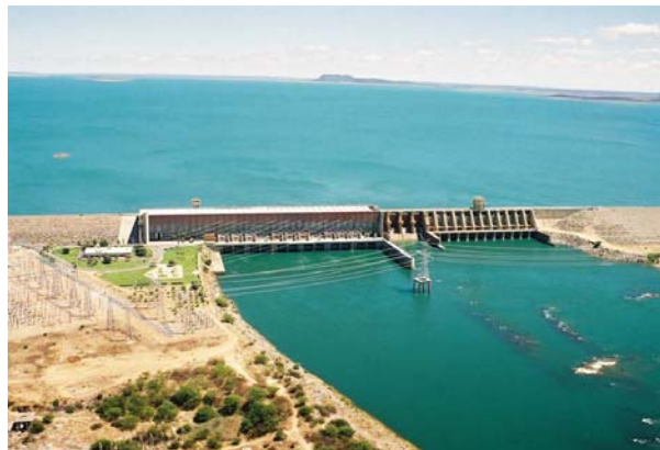
Figura 40 - Casa de força e vertedouro da barragem de Sobradinho. Fonte: AGÊNCIA NACIONAL DE ÁGUAS (2004b).
