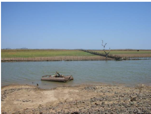
Foto 113 - Área próxima ao reservatório na localidade de basuá. Coordenadas 9° 47' 19" e 41° 38' 03".
