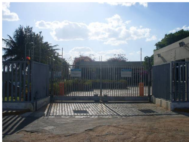
Foto 72 - Portão central da Sede administrativa da CHESF de Sobradinho. Coordenadas 9° 28' 29" e 40° 48' 45".
