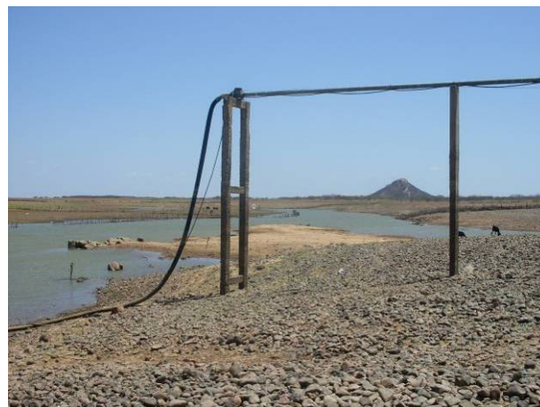
Foto 114 - Área próxima ao reservatório na localidade de Basuá. Edificação utilizada para a irrigação. Coordenadas 9° 47' 19" e 41° 38' 03".
