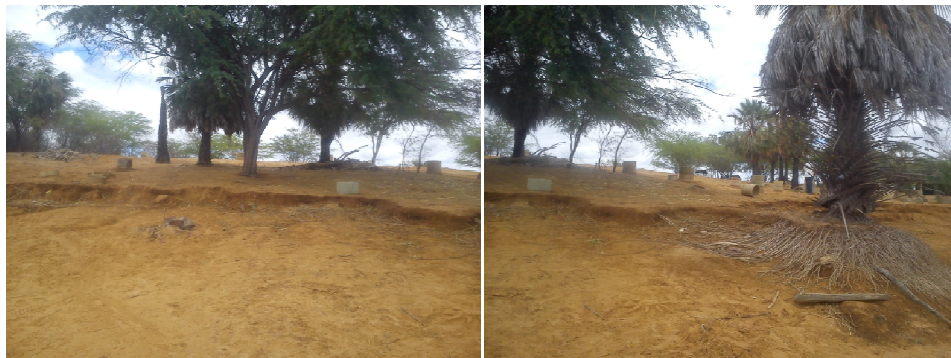
Figura 6.17– Vistas do barranco à beira do rio São Francisco, na estação de monitoramento EM 1.3.
