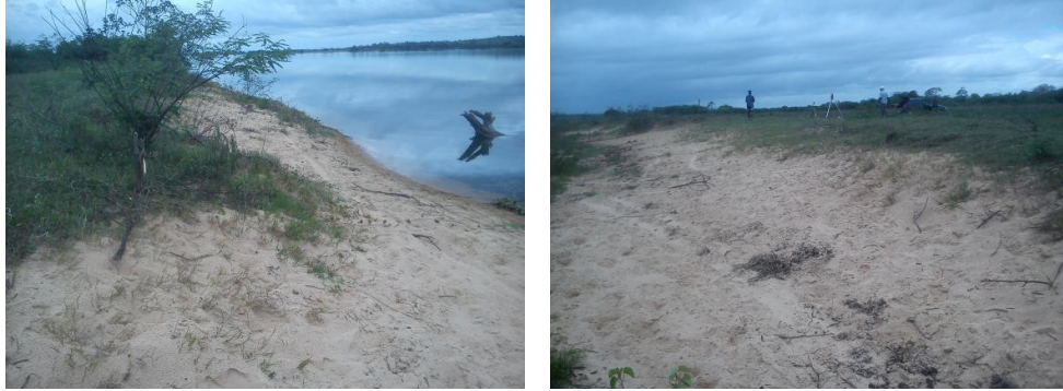
Figura 6.30 - Vistas do talude na estação M 5.2, constituído por solo arenoso.
