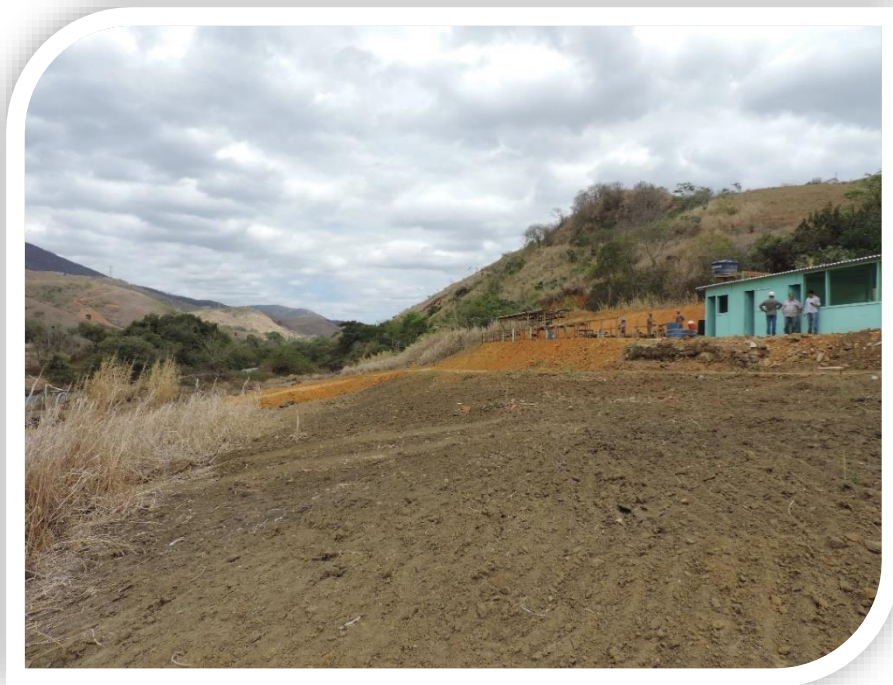
Figura 10: Área 2A. Fotografia ilustrando a disposição espacial do trecho de conexão da ponte com a estrada vicinal de acesso a UHE Simplício. Na imagem é possível observar o início das atividades de instalação do canteiro de obras, e de terraplanagem no local (17 out/2017).
