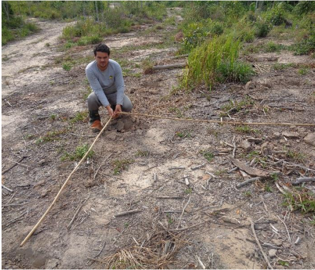
Foto 19: Verificação do espaçamento de covas.
