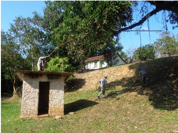
Foto 75: Retirada de tubulação.
