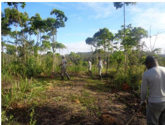
Foto 3: Roçada na via de acesso e limpeza.
