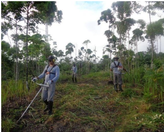
Foto 1: Funcionários realizando limpeza de aceiro.
