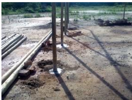
Foto 45: Reforço com concreto nos moirões mais requisitados.
