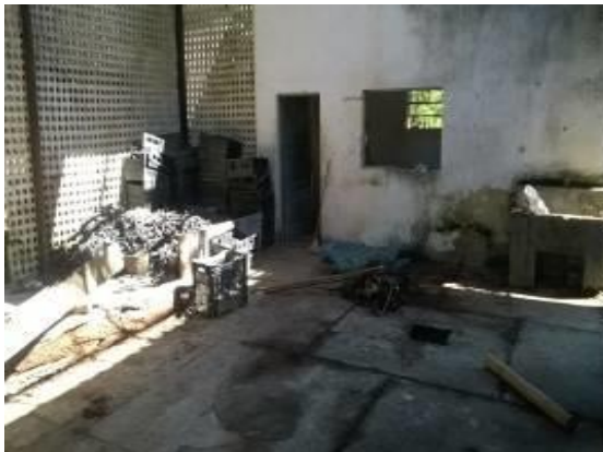
Foto 41: Área de substrato sendo limpa.
