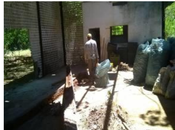
Foto 42: Remoção de tubetes e colocados em sacos plásticos.
