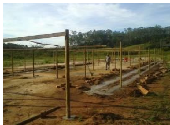
Foto 31: Visão geral das sementeiras e mourões para construção do viveiro.
