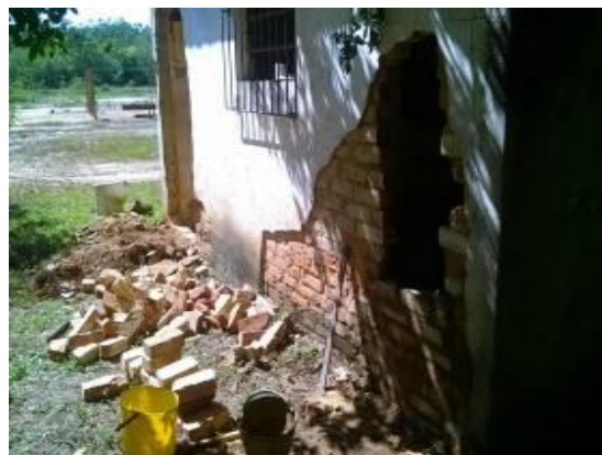
Foto 36: Reforma da área externa da sala de ferramentas.
