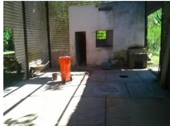
Foto 40: Área de substratos após A remoção de resíduos e limpeza.
