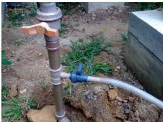
Foto 50: Encanamentos pré fixados, detalhe do registro.
