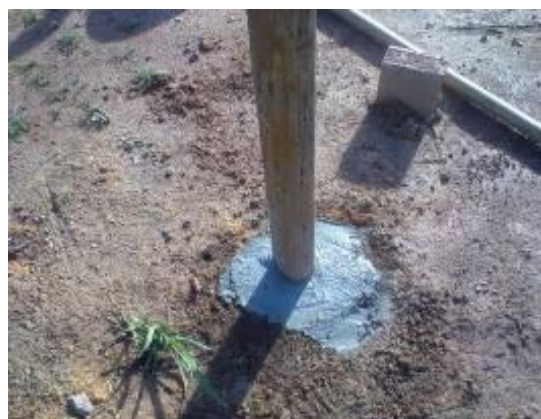
Foto 46: Reforço com concreto nos moirões mais requisitados.
