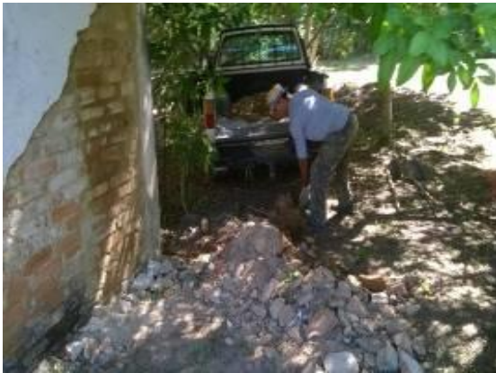
Foto 39: Remoção de todo material utilizado durante a obra.
