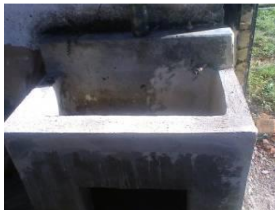
Foto 44: Tanque depois da reforma.
