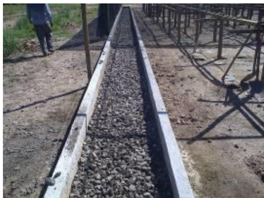
Foto 32: Camada de brita no fundo das sementeiras.
