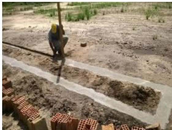
Foto 29: Preenchimento de valas com concreto para as sementeiras.
