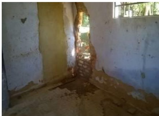
Foto 35: Limpeza e reconstrução da área interna da sala de ferramentas.
