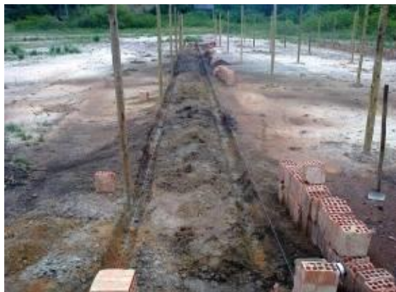
Foto 28: Abertura de valas para preenchimento.
