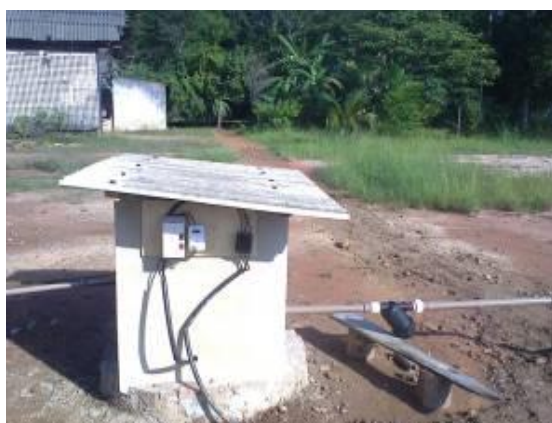
Foto 52: Estrutura de alvenaria com sistema de irrigação.
