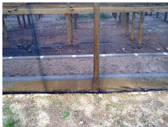
Foto 59: Sombrite das laterais recolocado para que se chegasse ao chão.
