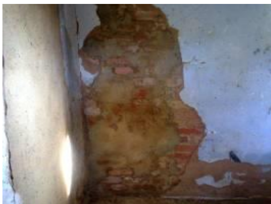
Foto 37: Tijolos assentados onde havia um buraco.
