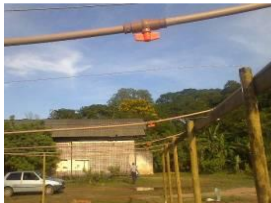
Foto 51: Encanamentos pré fixados, detalhe do registro.
