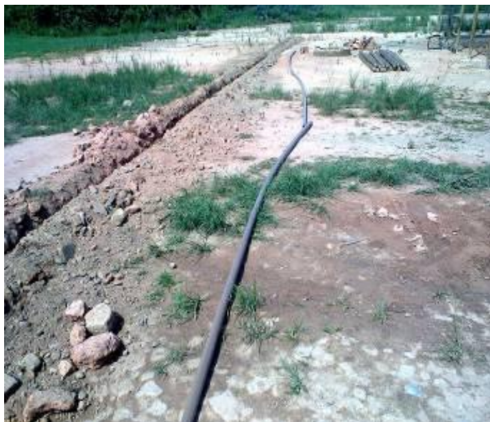
Foto 49: Vala escavada a esquerda para passagem de tubulações.
