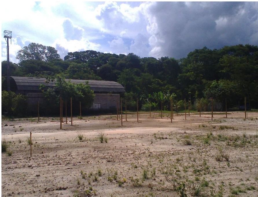
Foto 23: Vista geral do viveiro em construção onde se pode observar todas as estacas da estrutura principal fixadas.
