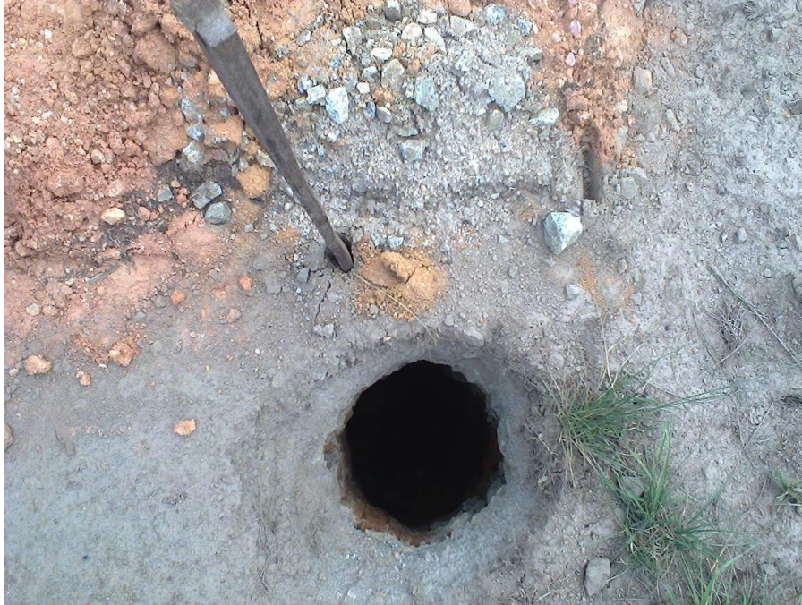
Foto 19: Buraco furado. Primeira camada do solo muito compactada e com pedras.
