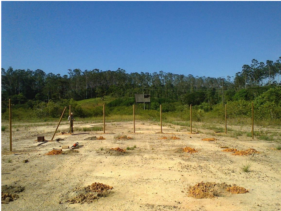
Foto 21: Detalhe das primeiras estacas sendo fixadas.
