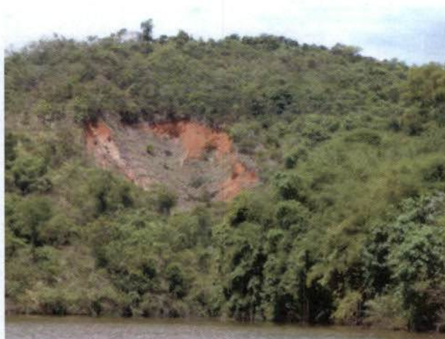
Foto 39: Vista geral da Erosão 3.
