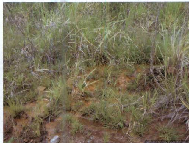
Foto 04: Mina d'água permanente no pé do bota-fora 05 / BR 393, sem qualquer tratamento.
