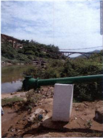
Foto 47: Instalação da futura captação da CEDAE em Sapucaia/RJ.
