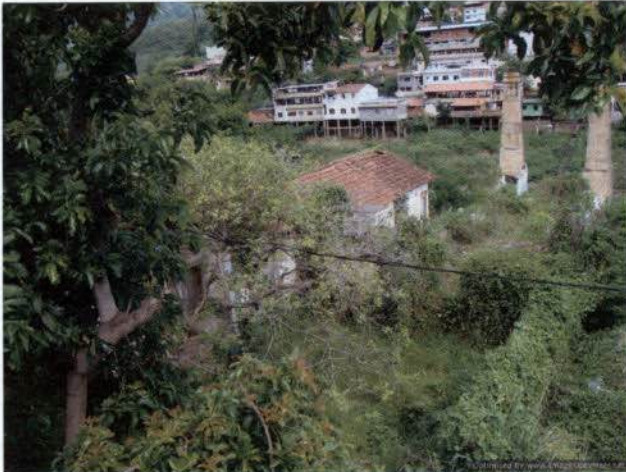
Foto 49: Construções abandonadas na lateral da ETE Sapucaia de Minas, Chiador/MG.
