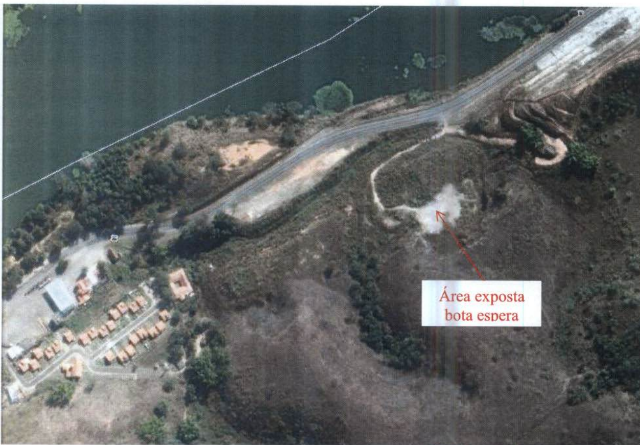
Imagem 5-4 – (Imagem do Google Earth) Vista aérea do atual estágio de recuperação do Bota Fora 5 da BR393
