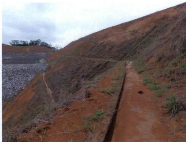
Foto 25: Esterco de gado em canaleta do Dique Sul.
