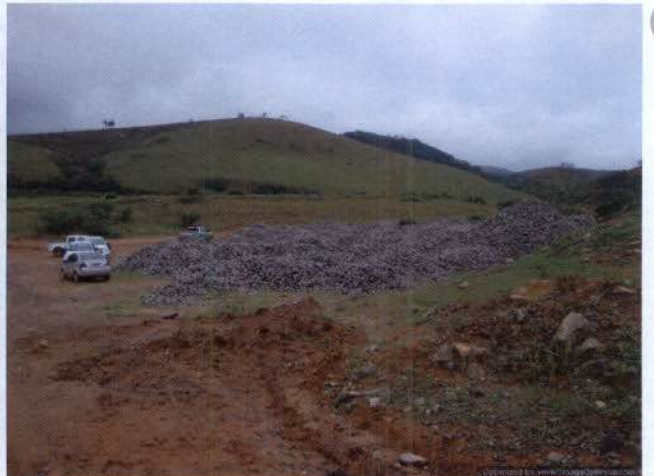
Foto 32: Bota-espera não apresentada no projeto com enrocamento para construção de berna de equilíbrio, espalhada pela área.
