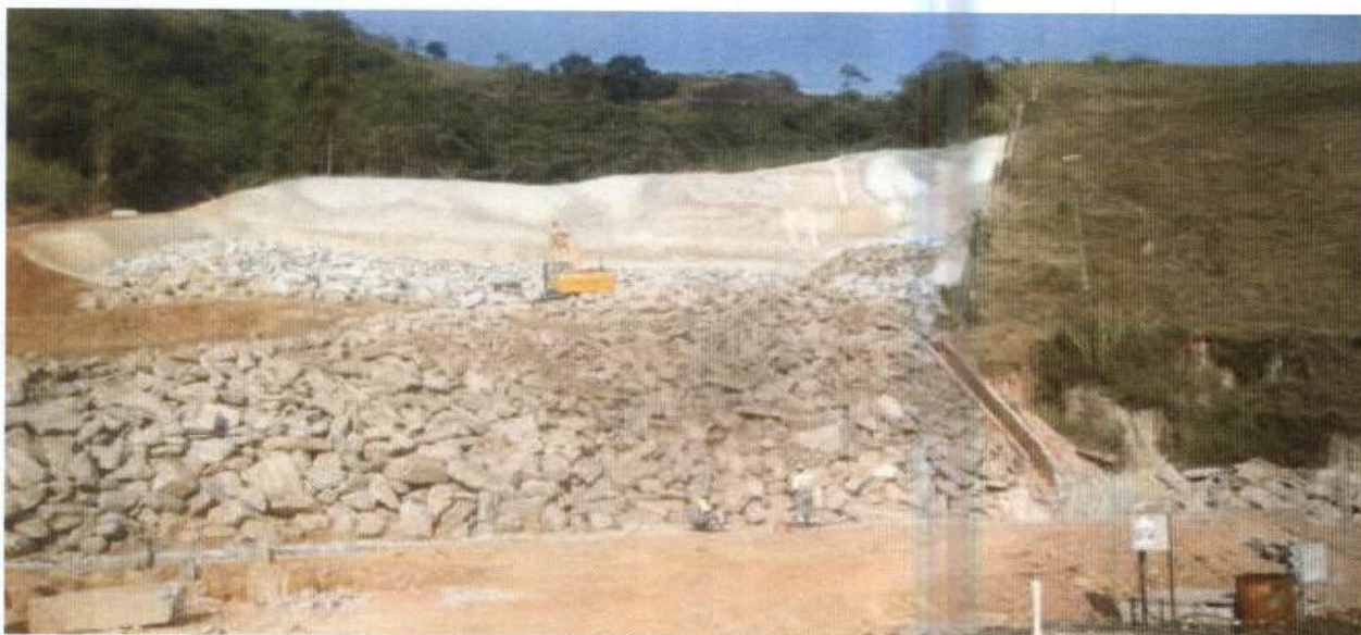
Imagem 5-3 – Vista geral da proteção do talude da Subestação da UHE Anta.
