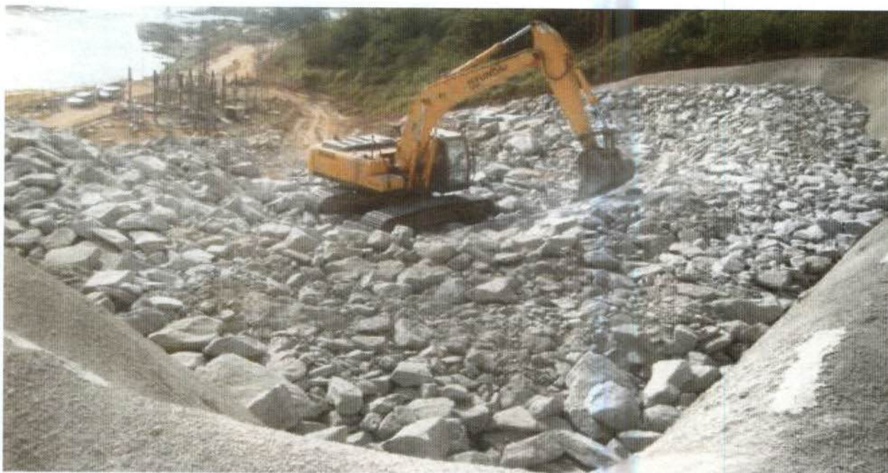
Imagem 5-2 – Atividades de proteção do talude da Subestação de Anta com rocha proveniente do BF 5 da BR 393.
