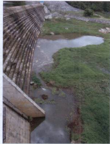
Foto 54: Abertura d canais de comunicação entre poças de jusante.
