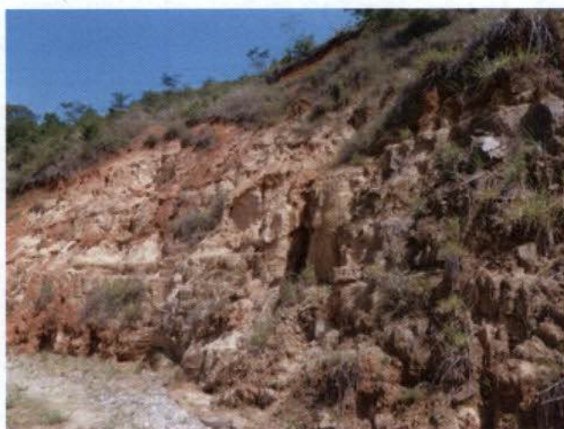
Foto 05: Talude da estrada de serviço junto à ombreira esquerda do dique Louriçal 1, mostrando importante ravinamento.
