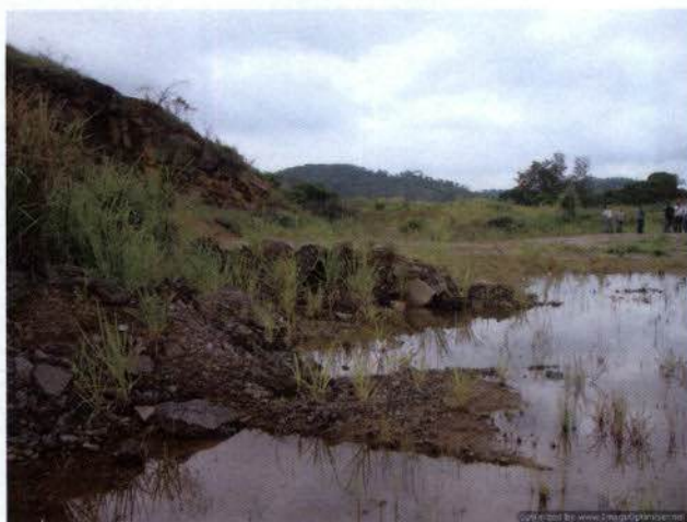
Foto 03: Bota-fora 05 da BR 393 não recuperado com presença de rejeitos de manta asfáltica e lixo.
