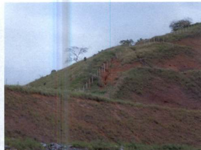
Foto 28: formação de processo erosivo ao longo de cerca – Desemboque Canal 5.
