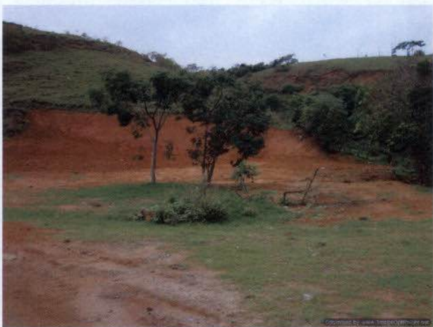
Foto 33: Abertura de área de empréstimo não prevista em projeto e sem autorização do Ibama. Ponto GPS 094.
