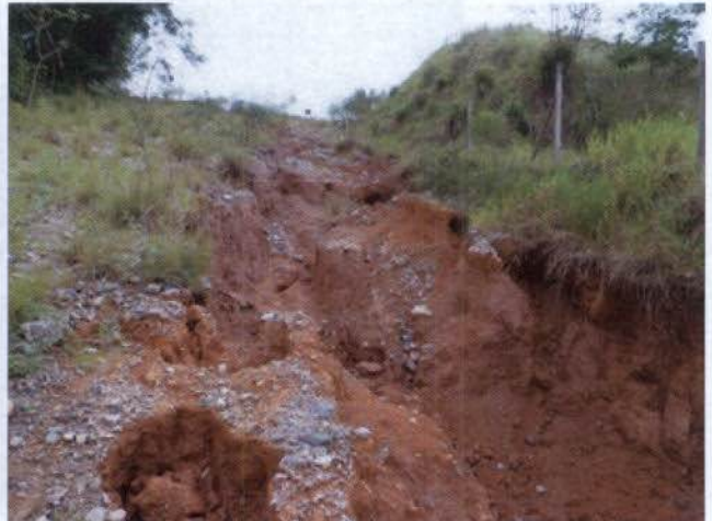
Foto 44: processo erosivo em desenvolvimento na estrada de acesso ao Bota Fora 17.
