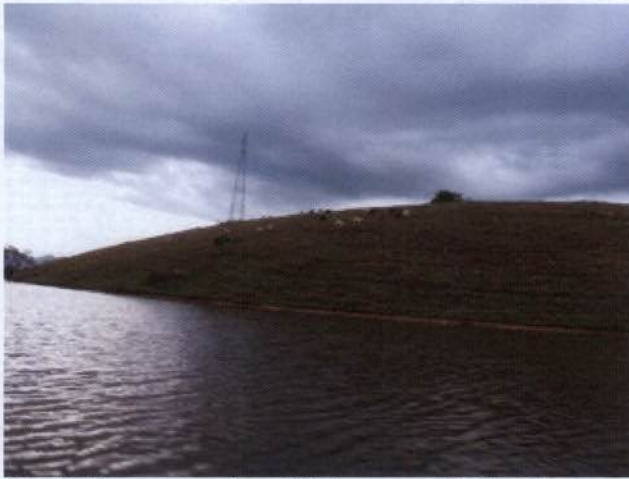
Foto 19: Presença de gado na APP do reservatório Calçados.
