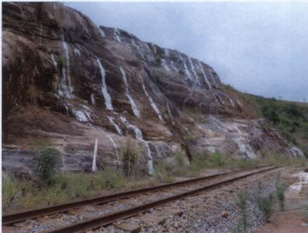
Foto 21: Tela de alta resistência com chumbadores em talude em rocha.
