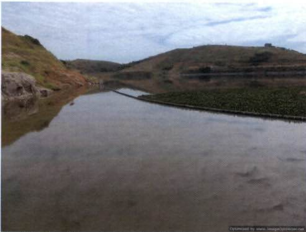
Foto 57: Macrófitas afastadas da saída do STP.
