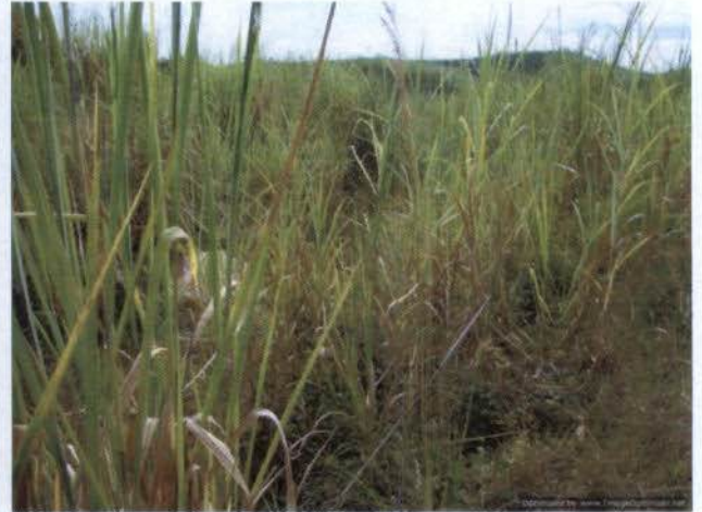
Foto 02: Bota fora 05 / BR 393 – dreno tomado por vegetação, não permitindo avaliar técnica corretiva.
