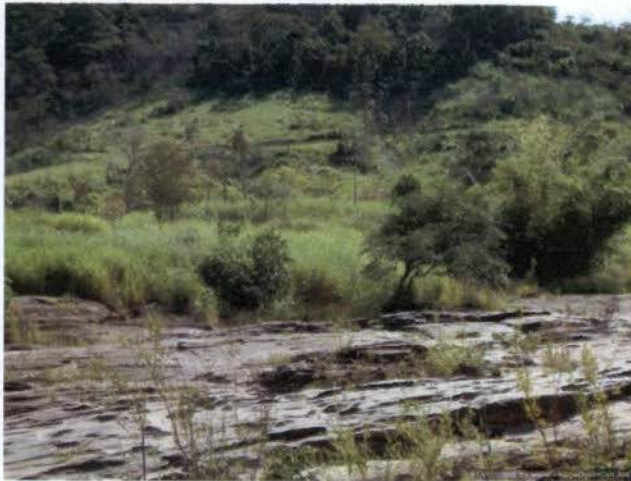
Foto 45: Margem esquerda onde se implantará via de acesso à ponte, paralelo à FCA.
