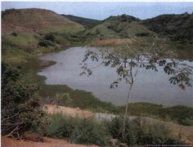
Foto 13: Presença de Macrófitas a montante da usina Anta, na área do Antigo lixão de Anta.
