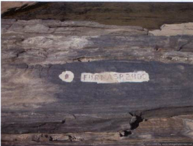
Foto 37: Marcação sondagem pretérita (2009) do eixo da ponte.
