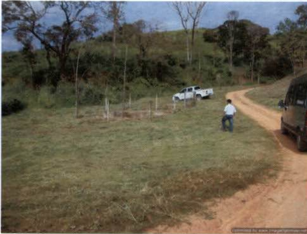
Foto 43: ETE localizada na sede da Fazenda Simplício/CGA.
