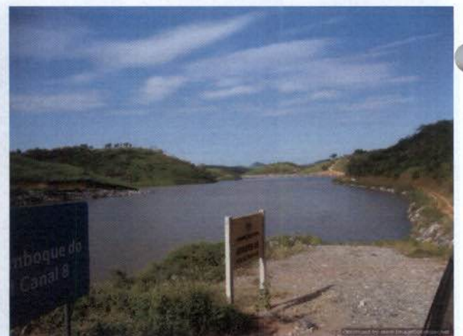
Foto 18: Aspecto qualidade da água no reservatório de Peixe.
