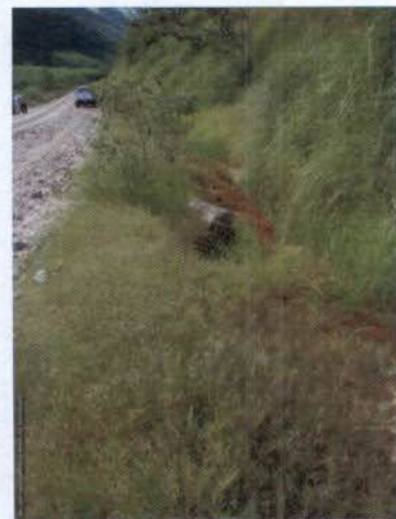
Foto 06: Dreno lateral beirando Talude do trecho 1 da MG 126.
