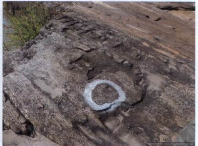
Foto 38: Ponto de possível localização de um dos pilares da Ponte, identificado como TB3.
