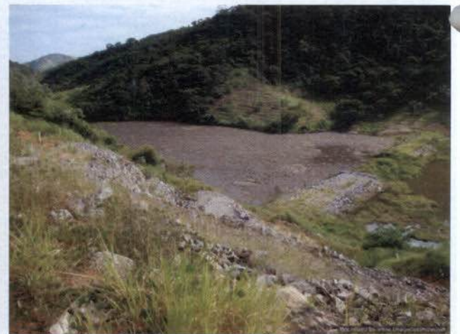
Foto 16: Jusante do Dique Alga 2 tomada por macrófitas mortas.
