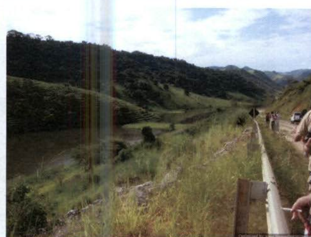
Foto 22: Aspecto qualidade da água no braço Louriçal, montante do dique Alga 2.
