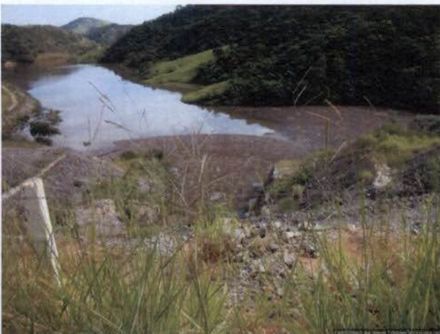
Foto 17: Emboque do Túnel C5 ocupado por macrófitas mortas. Material em decomposição observado ao longo do reservatório Louriçal.
