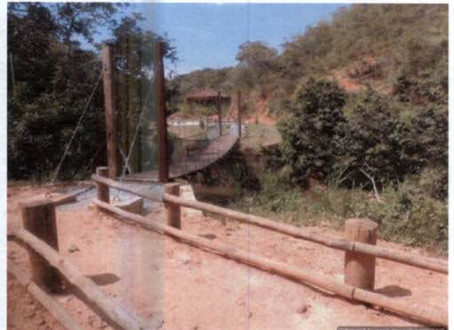
Foto 70: Final da trilha Estação Simplício / Cemitério dos Turcos. Ponte suspensa sobre o córrego dos Peixes.
