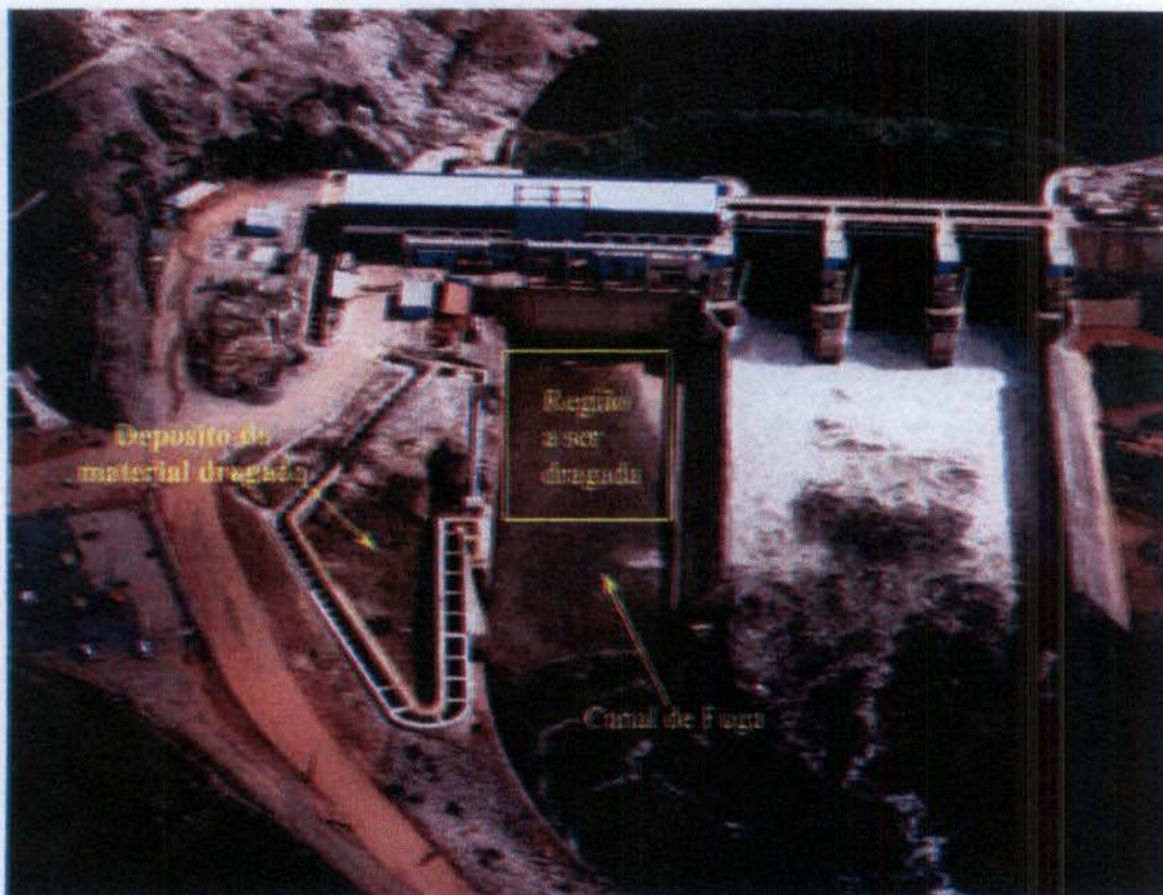
Foto 2 - Vista geral do Canal de Fuga e do local de deposito do material dragado
