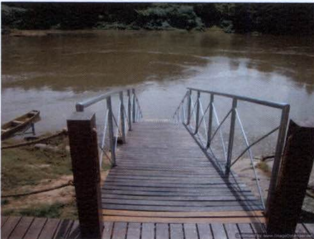
Foto 75: Deck de acesso ao rio Paraíba do Sul (TVR) no distrito de Anta, Sapucaia, RJ.
