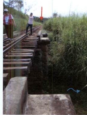
Foto 44: Ponte FCA sobre o córrego Simplício. Acesso ponte margem esquerda será a jusante seguindo paralelo. Adiante local onde haverá cruzamento com a via férrea.
