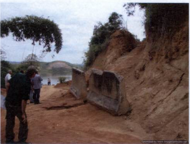
Foto 77: Passagem do acesso ilegal bloqueada por Furnas, junto ao acesso ao Deck no reservatório de Anta próximo ao antigo lixão de Anta.
