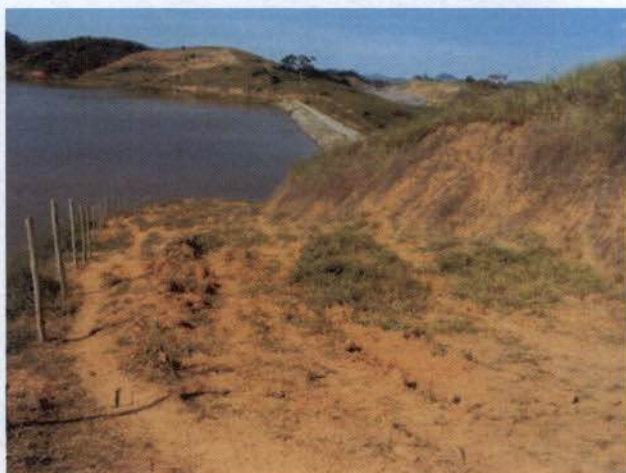
Foto 63: Acesso à água, Reservatório Antonina
