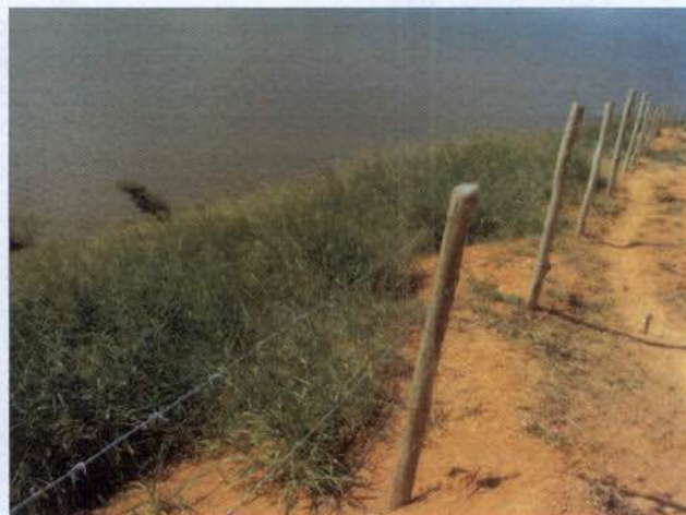
Foto 62: Reservatório de Antonina, área de plantio, sem manutenção, cercada.
