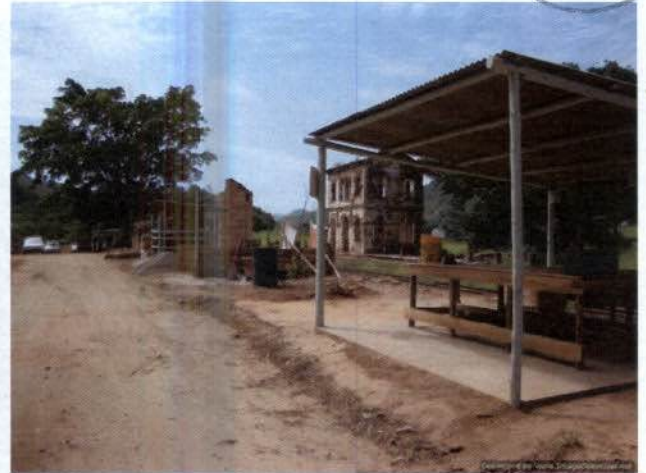
Foto 68: Restauração da antiga estação Simplício em andamento.
