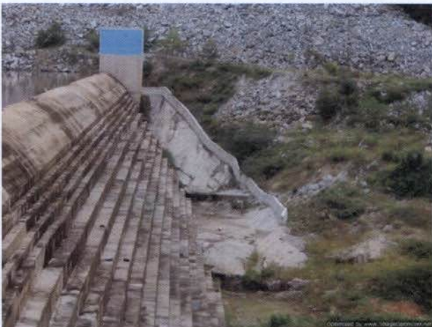
Foto 53: Estrutura no local da mortandade de peixes.
