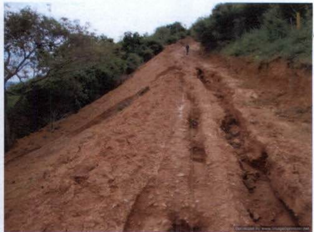
Foto 78: Impacto provocado pela abertura do acesso ilegal na APP de Furnas. Local de elevada declividade com sulcos erosivos acentuados.
