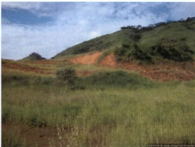
Foto 07: Aspecto da Área de empréstimo das obras de relocação da MG 126 próxima à VCH13.
