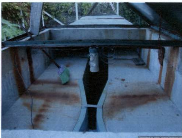
Foto 35: Sensor ultrassônico de vazão de efluente, ETE Sapucaia.
