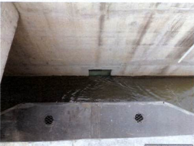
Foto 59: Afunilamento do canal do STP para permitir melhor visualização dos peixes pela janela da sala de monitoramento.
