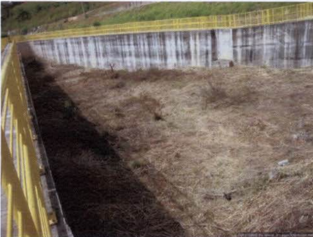
Foto 15: Célula entre STP, usina Anta a ser depositado material a ser dragado do canal de fuga.
