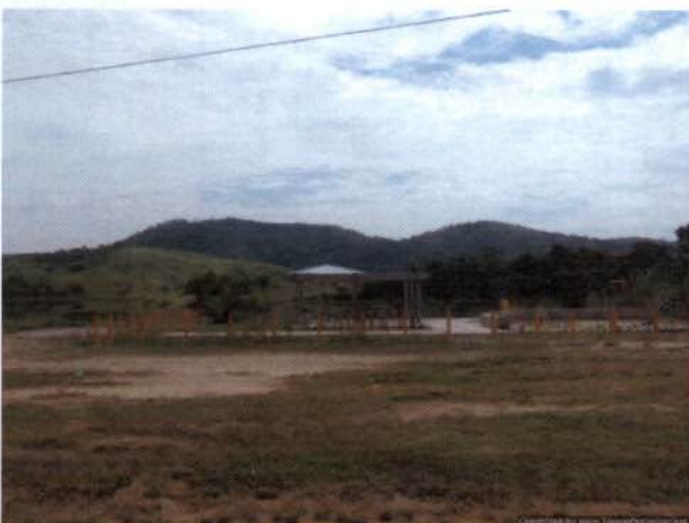
Foto 71: Deck de acesso ao reservatório de Anta, próximo ao Bairro 21.
