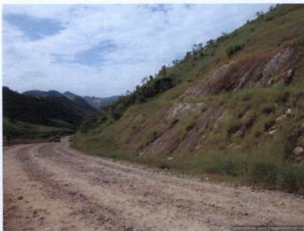
Foto 05: Talude recuperado sobre Emboque do Túnel C5, Trecho 1 da MG 126.
