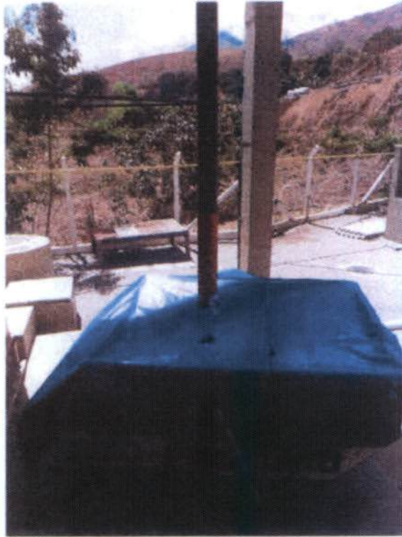
Figura 2.2 - Tambor destinado a resíduos sólidos gerados na ETE Sapucaia - RJ
