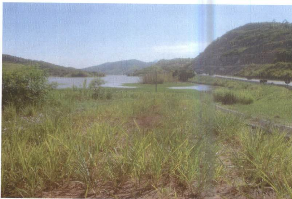
Foto 2.2.2-3 – Vista do trecho após a conclusão da remoção do pavimento, já em estágio avançado de recobrimento vegetal das áreas expostas.
