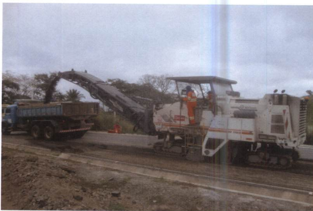
Foto 2.2.2-1- Vista da remoção do pavimento por meio de fresadora.
