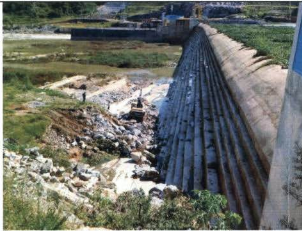
Foto 1: Vista do local antes da intervenção (ombreira esquerda).
