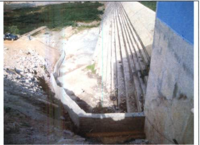
Foto 2: Vista do muro pronto (ombreira esquerda).
