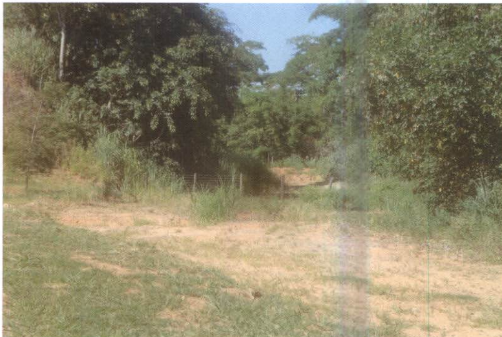
Foto 2.1.1-2 – Vista do trecho após a conclusão da remoção do pavimento, já em estágio avançado de recobrimento vegetal das áreas expostas.
