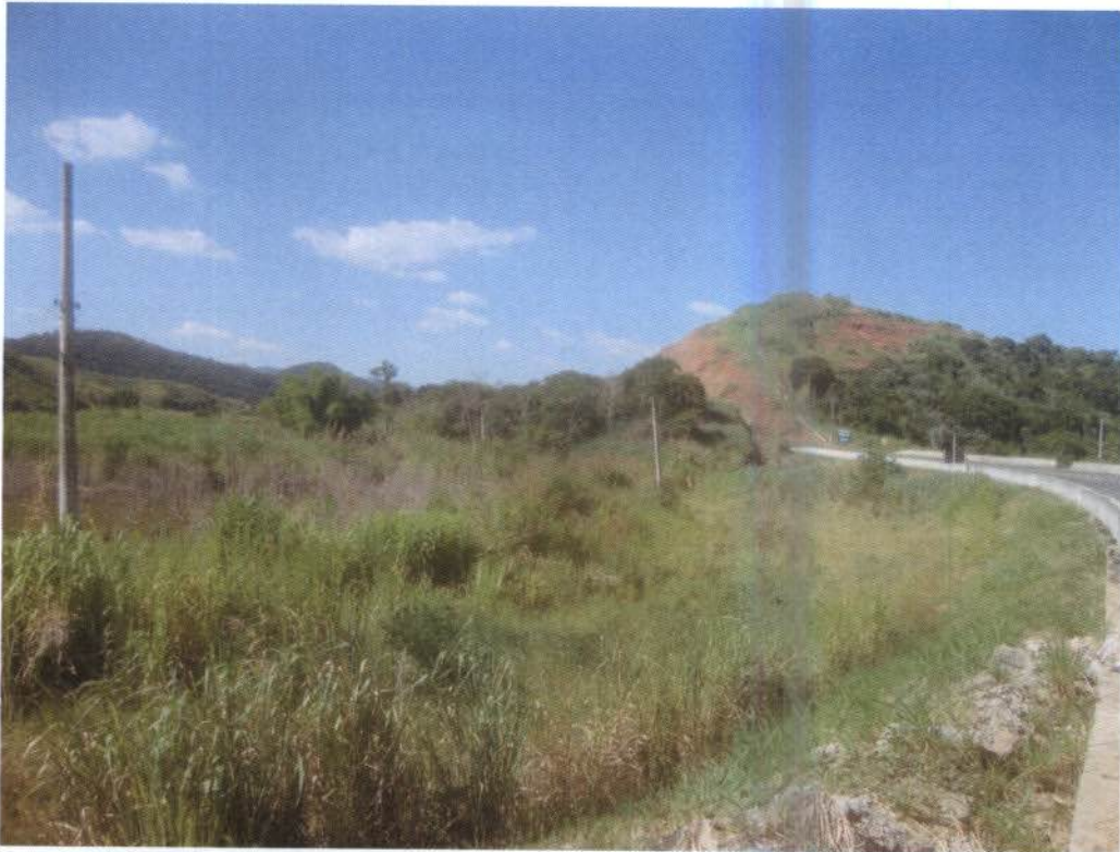
Foto 2.3.1-1 – Vista do trecho após a conclusão da remoção do pavimento, já em estágio avançado de recobrimento vegetal das áreas expostas.
