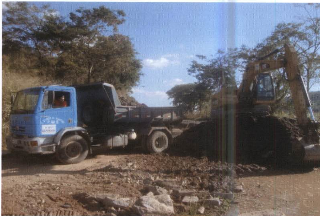
Foto 2.1.2-1 – Vista da remoção de pavimento.
