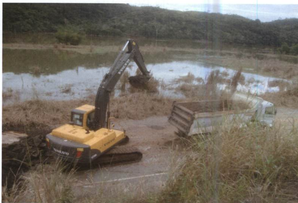
Foto 2.1.4-1 – Vista da remoção do pavimento.
