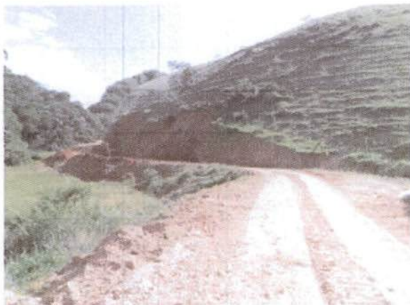
Foto 001 - Retrata parcialmente estrada de acesso implantada
