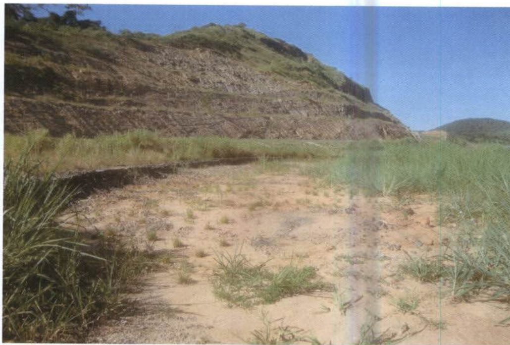
Foto 2.2.1-2- Vista do trecho após a conclusão da remoção do pavimento, já em estágio avançado de recobrimento vegetal das áreas expostas.
