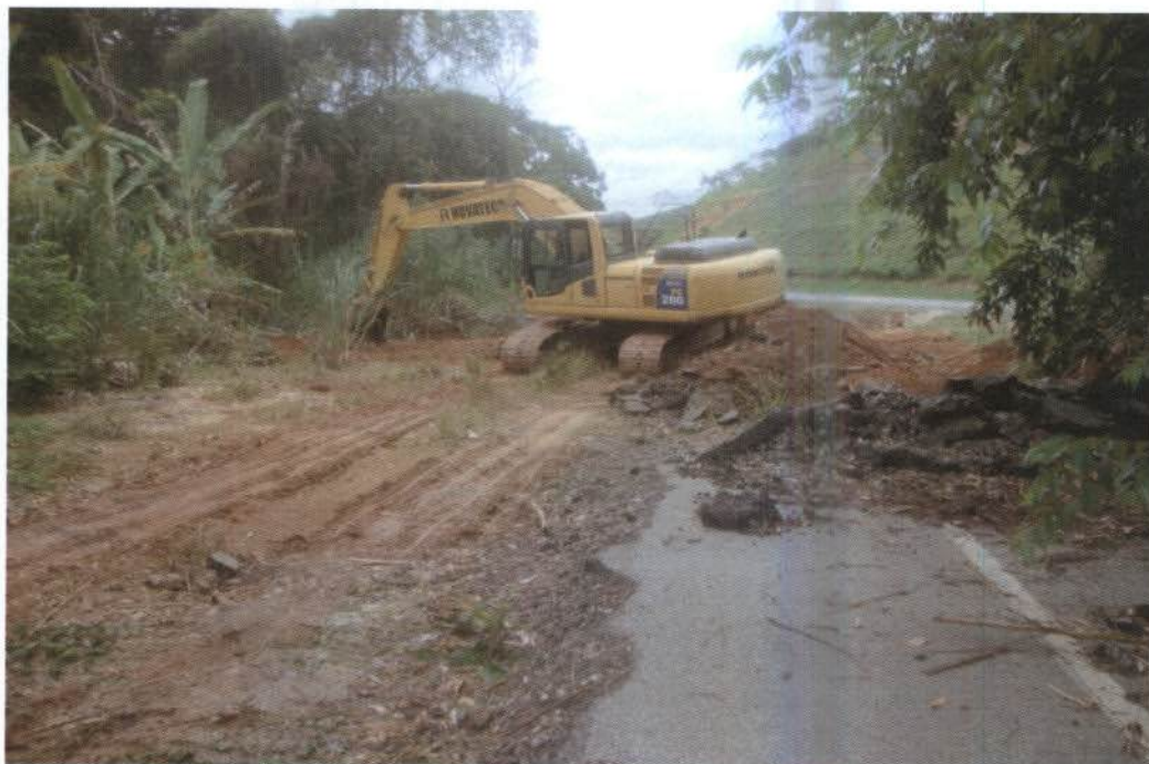
Foto 2.1.1-1 – Vista da remoção do pavimento.
