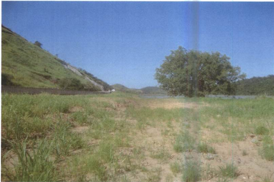
Foto 2.1.4-2 – Vista do trecho após a conclusão da remoção do pavimento, já em estágio avançado de recobrimento vegetal das áreas expostas.
