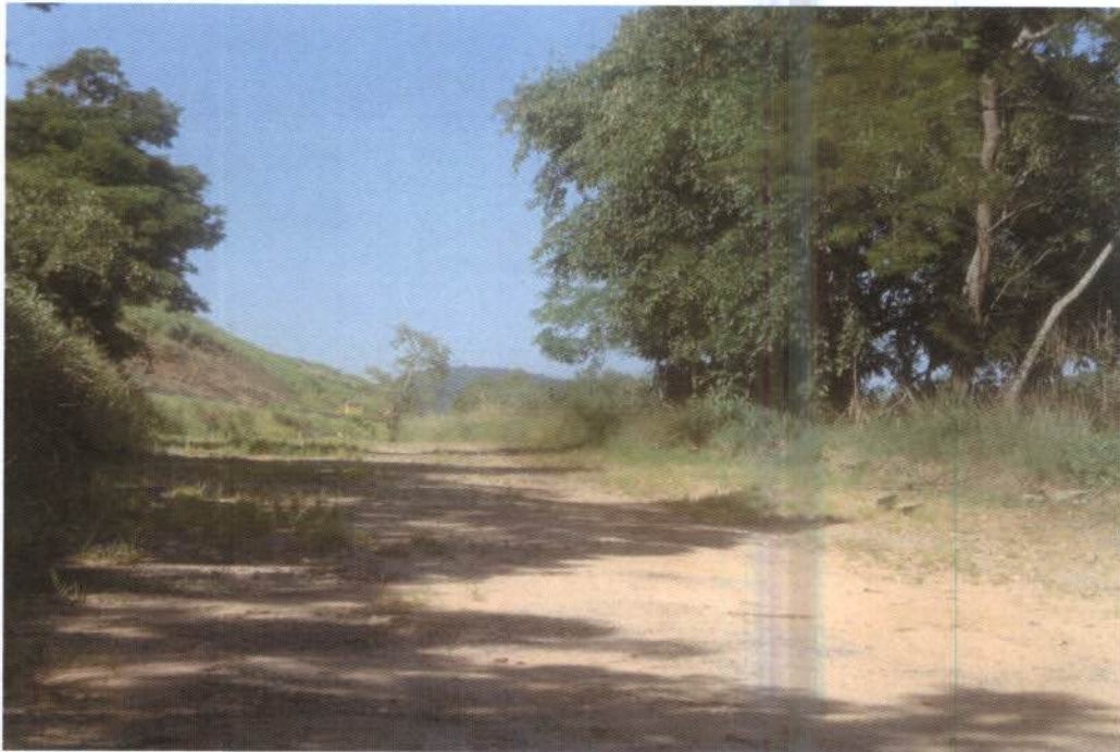
Foto 2.1.2-2 - Vista do trecho após a conclusão da remoção do pavimento, já em estágio avançado de recobrimento vegetal das áreas expostas.
