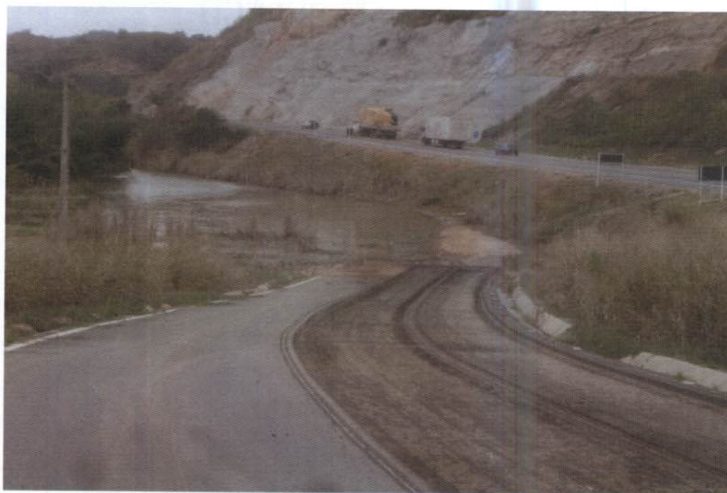
Foto 2.2.2-2- Vista da remoção parcial do pavimento realizado pela fresadora.
