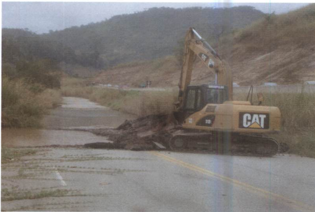
Foto 2.1.3-1 - Vista da remoção do pavimento.
