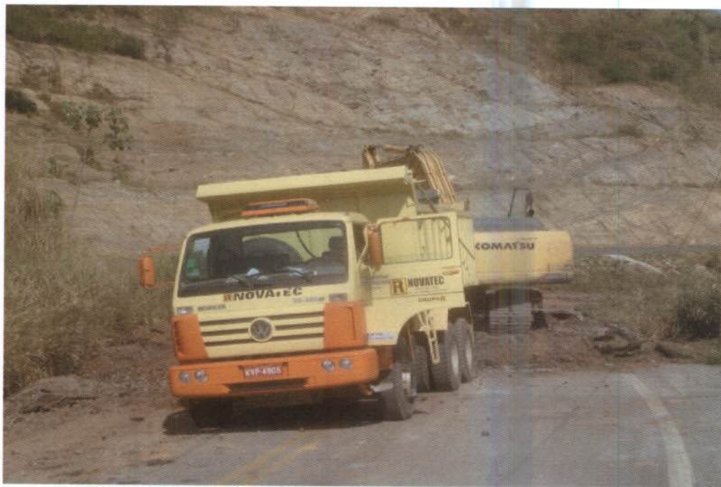
Foto 2.2.1-1- Vista da remoção do pavimento.
