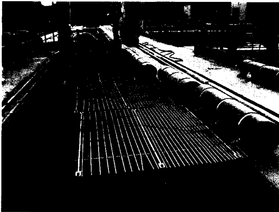
Foto 2.2-3- Vista da Montagem da Grade e Boia do Log Boom.
