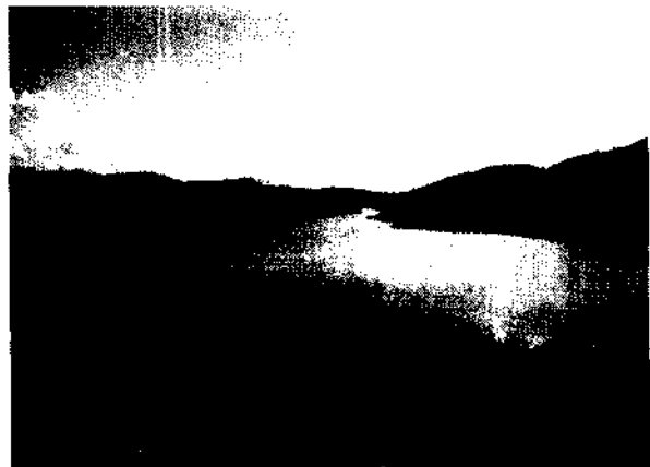
Foto 2.1.4-4 Vista do reservatório de Antonina.
