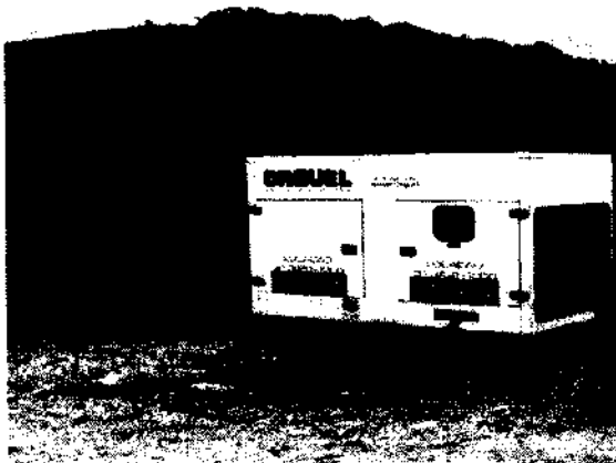
Foto 2.1.4-1 Gerador utilizado para execução do bombeamento.
