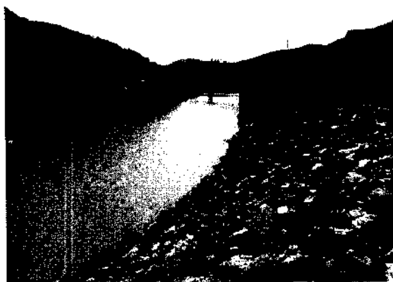
Foto 50: Canal de Fuga UIIE. Simplicio. Detonação enseadeira efetivada. Entrada de água proveniente do rio Paraíba do Sul.
