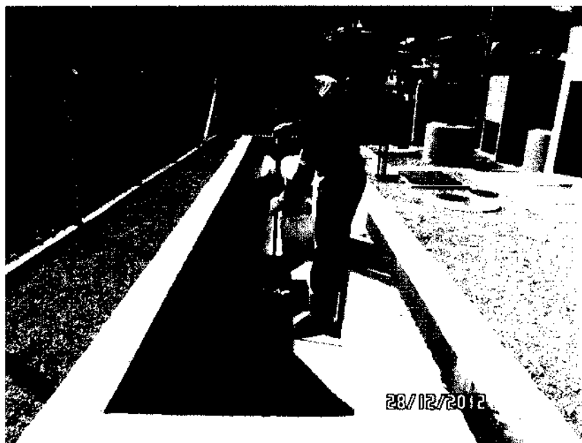
Foto 5.3-2 – Operação da ETE - Limpeza de sólidos grosseiros no canal de entrada
