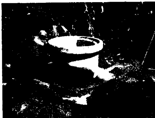
Detalhe da instalação das manilhas
