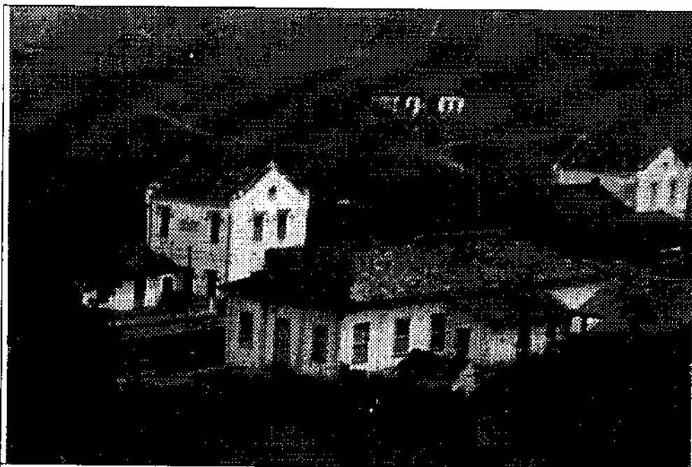
Figura 02 - A estação de Chiador quando ainda funcionava e ainda inteira. A foto é de 1948.
