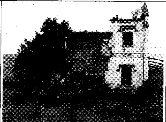
Figura 13 – Torreão esquerdo em processo de arruinamento.
