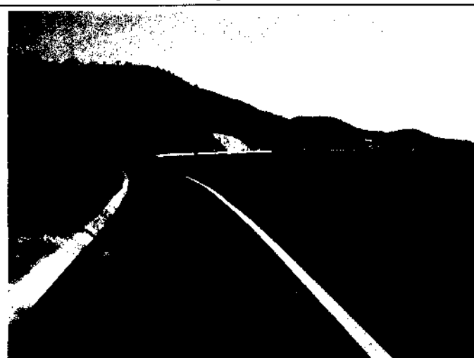
Foto 107: Trecho 1 da BR 393 já concluído com instalações de drenagem.
