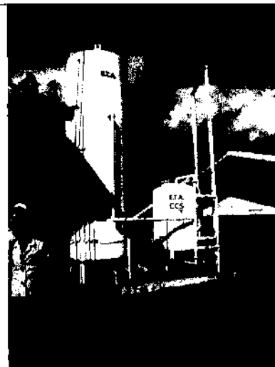
Foto 56: ETA do canteiro de obra da usina de Simplício. Captação de água realizada do Ribeirão dos Peixe.
