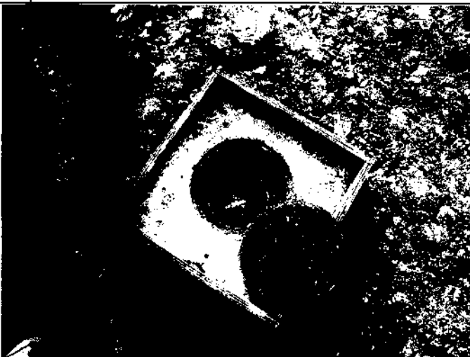
Foto 65: Estação de monitoramento de lençol freático do aterro sanitário próximo à janela 2 do túnel 3.
