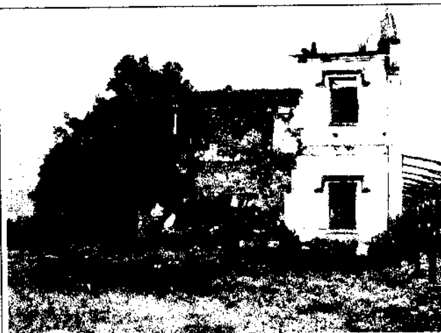
Figura 13 – Torreão esquerdo em processo de arruinamento.
