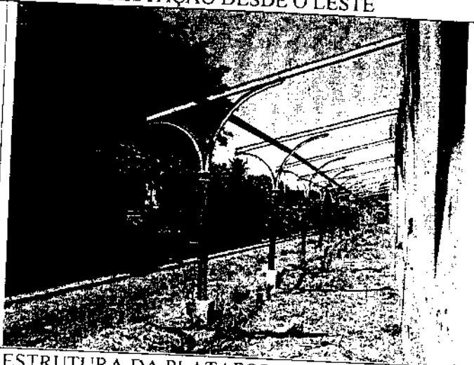
ESTRUTURA DA PLATAFORMA
