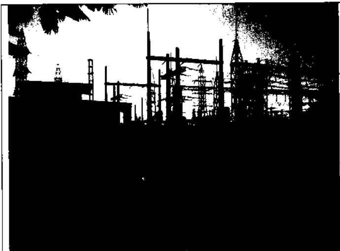
Foto 67 - Subestação Rocha-Leão, de propriedade da Ampla
