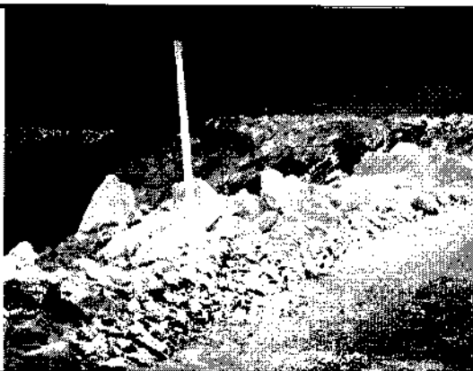
Foto 17 - Pedras utilizadas no enrocamento dos taludes dos acessos prejudicando a vegetação remanescente.
