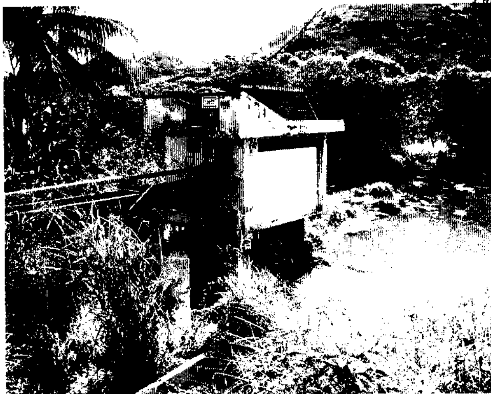
Foto 1 - Atual localização da captação de água da CEDAE para abastecimento do município de Sapucaia. Esta captação será relocada para um trecho de maior vazão do rio Paraíba do Sul.
