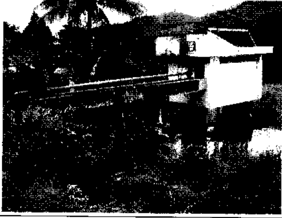
Foto 13 - Captação de água da CEDAE, em Sapucaia, Trecho de Vazão Reduzida.
