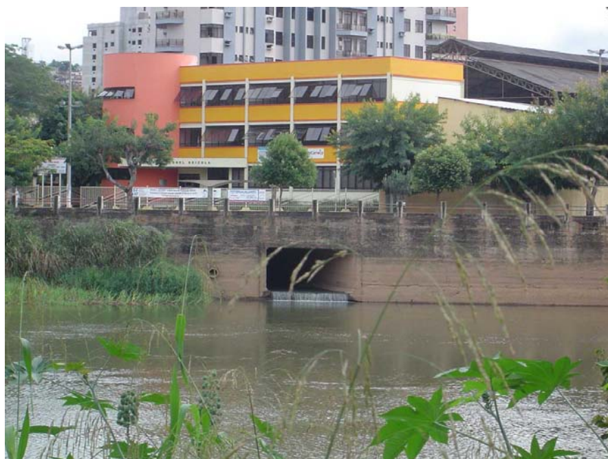
FIGURA 26 FOZ DO CÓRREGO DOS PURYS NO RIO PARAÍBA DO SUL, QUE RECEBE OS ESGOTOS DOMÉSTICOS DA MAIOR PARTE DA CIDADE DE TRÊS RIOS (N 7552921 / E 685059)
