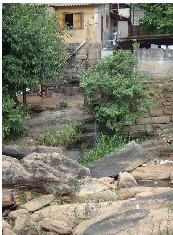
FIGURA 14 LANÇAMENTO DE ESGOTO NO RIO PARAÍBA DO SUL ATRAVÉS DA REDE DE DRENAGEM NO CENTRO DE SAPUCAIA. OUTRO EXEMPLO DE POLUIÇÃO DIFUSA. (N 7555281 / E 689279)
