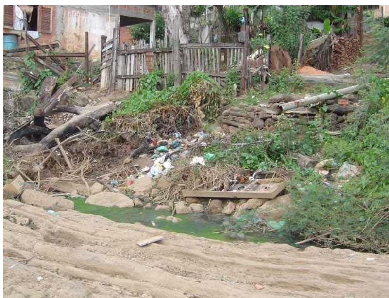
FIGURA 16 LANÇAMENTO DIRETO DE ESGOTO RESIDENCIAL NO BRAÇO DIREITO DA ILHA DE SAPUCAIA(N 7566236 / E 715070)
