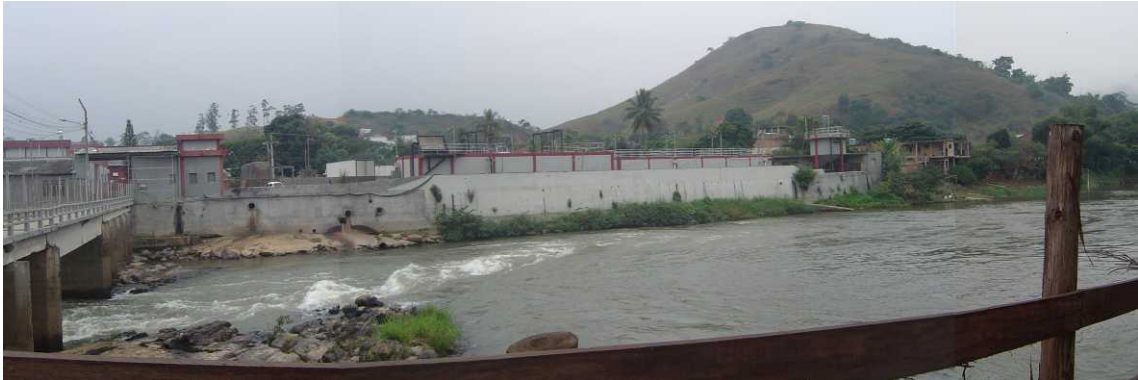
FIGURA 19 VISTA DA ESTAÇÃO DE TRATAMENTO DE EFLUENTES DA INDÚSTRIA SOLA S.A. NA MARGEM DO RIO PARAÍBA DO SUL EM TRÊS RIOS (N 7553044 / E 687103)
