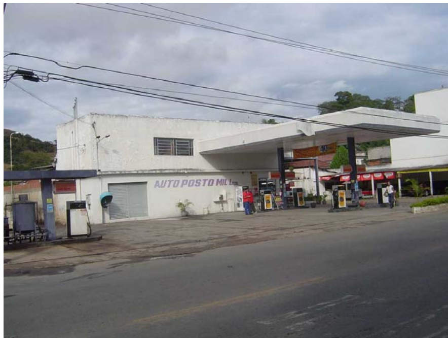
FIGURA 22 FONTE POTENCIALMENTE POLUIDORA: AUTO POSTO MIL LTDA. (N 7553039 / E 686665)
