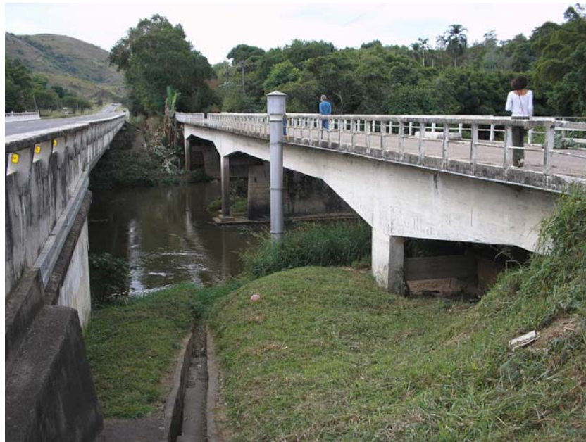
FIGURA 2.7 POSTO FLUVIOMÉTRICO FAZENDA BARREIRA NO RIO PIABANHA (BR-040) CONJUNTO DE RÉGUAS E LIMNÍGRAFO (MARGEM DIREITA)
