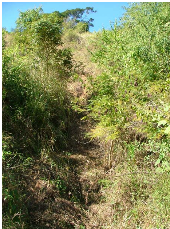
FIGURA 2.23 SULCO FORMADO PELO ESCOAMENTO DE ÁGUAS PLUVIAIS NA MARGEM DIREITA DO CANAL 2 DO EMPREENDIMENTO
