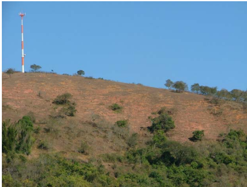
FIGURA 2.22 SINAIS DE EROSÃO LAMINAR EM ENCOSTA PRÓXIMO AO BARRAMENTO DE ANTA
