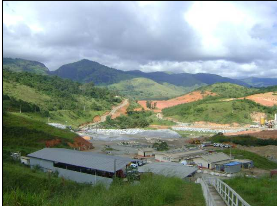
Figura 01 – Morros alongados na região a jusante do Reservatório de Calçado.
