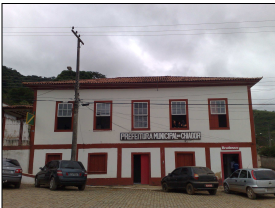
Figura 18 – Fachada da Prefeitura Municipal de Chiador – MG, onde se realizou entrevista com o Assessor de Infraestrutura e Obras Jan Carlos Araújo.
