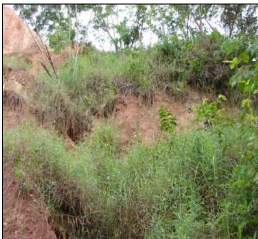
Figura 2.6 Desenvolvimento da vegetação em aterro decorrente do desmoronamento do talude da erosão
