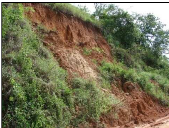
Figura 2.33 Vista a jusante da erosão 7
