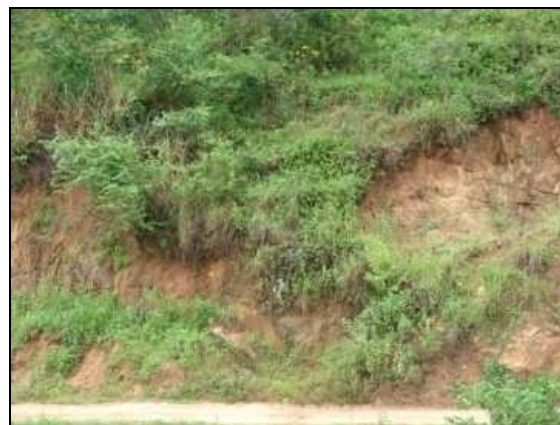
Figura 2.22 Presença de vegetação herbácea recém estabelecida nos taludes da erosão 4
