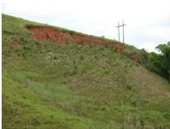
Figura 2.39 Vista frontal da porção direita da erosão 9, observa-se a proximidade desta com rede de distribuição de energia existente
