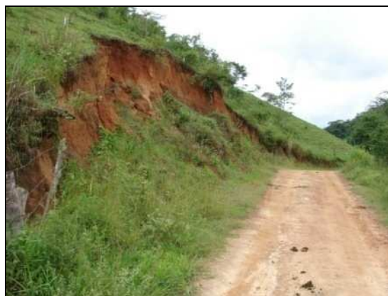
Figura 2.27 Detalhe lateral da erosão 6, verificando a proximidade deste processo erosivo com estrada atualmente utilizada
