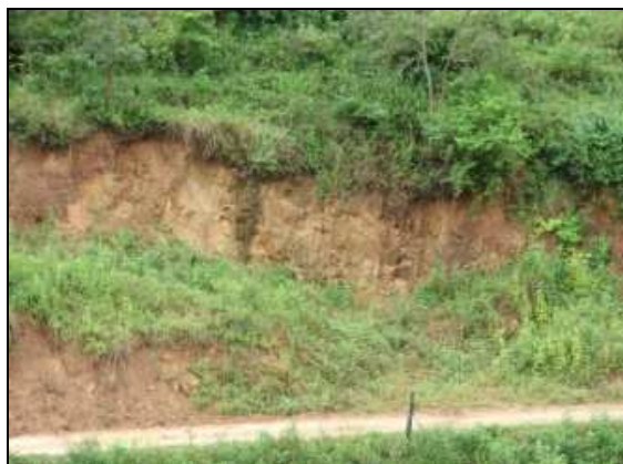
Figura 2.21 Detalhe de massa de solo recém mobilizada em deslizamento translacional ocorrido no local
