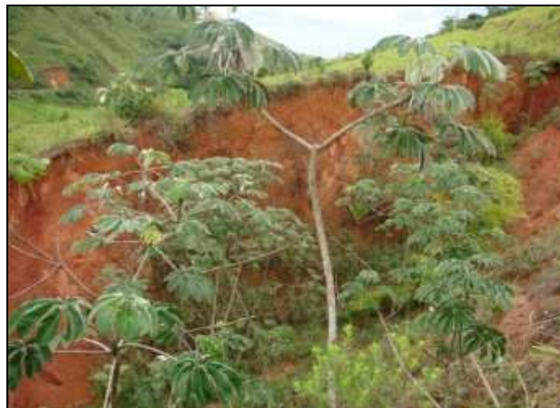
Figura 2.38 Detalhe do interior da porção esquerda da erosão 9
