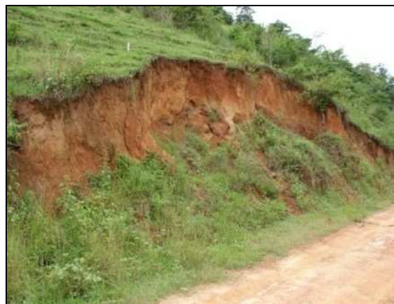
Figura 2.28 Vista frontal da erosão 6
