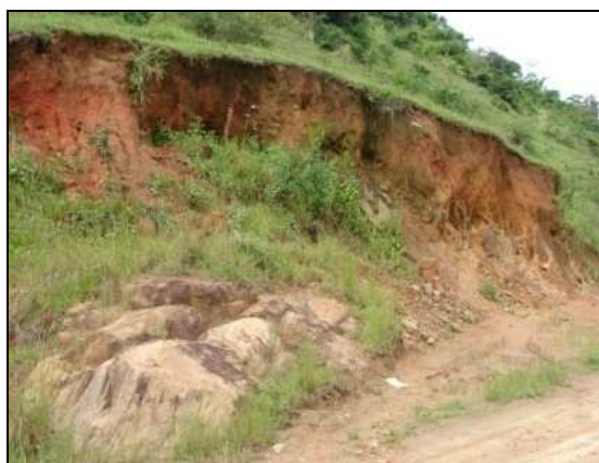
Figura 2.25 Detalhe a jusante da erosão 5, com a presença de vegetação herbácea estabelecida e a presença de sobre mobilizada em deslizamento translacional ocorrido no local
