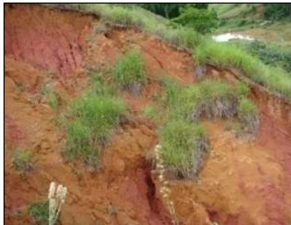
Figura 2.42 Detalhe de desmoronamento ocorrido na porção esquerda da erosão 9
