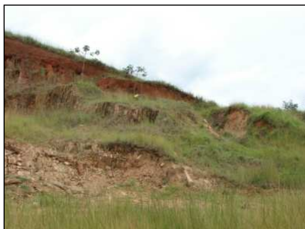
Figura 2.32 Vista frontal da porção lateral direita da erosão 7
