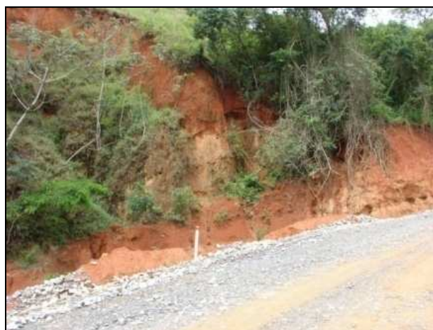
Figura 2.50 Detalhe da lateral direita da erosão 12
