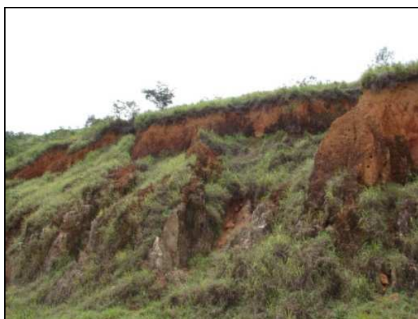
Figura 2.16 Vista a jusante da erosão, verifica-se o desenvolvimento de herbáceas em diversos pontos entre os sulcamentos desta erosão, ainda que insuficientes para promover a sua estabilização
