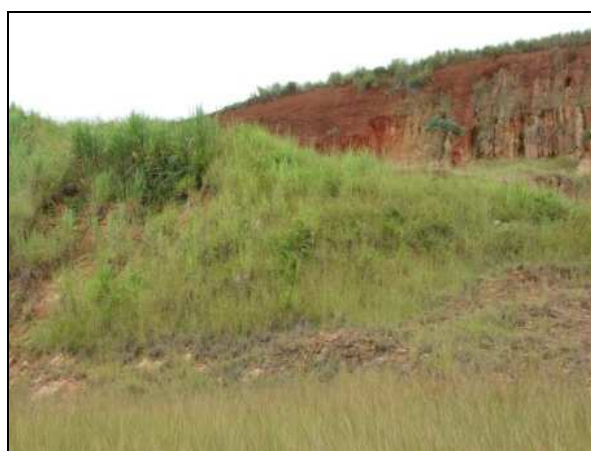
Figura 2.30 Vista frontal da porção lateral esquerda da erosão 7, observa-se o desenvolvimento de vegetação herbácea recém estabelecida
