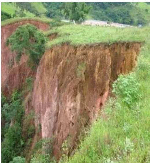
Figura 2.4 Detalhe de sulcamento semiestabilizado
