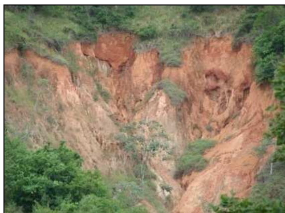
Figura 2.19 Vista geral da erosão 3, observa-se a grande massa de solo recém mobilizada, no centro da erosão
