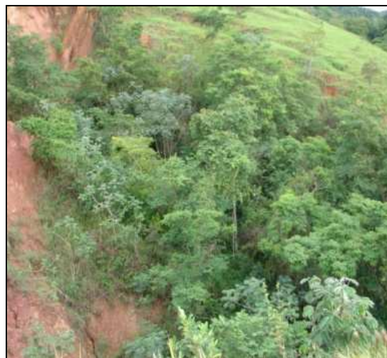
Figura 2.11 Vista geral do terço inferior da erosão, observa-se o pleno desenvolvimento de vegetação arbórea
