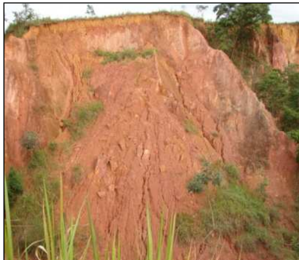
Figura 2.13 Massa de solo recém mobilizada por deslizamentos
