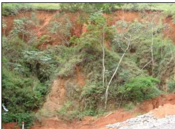
Figura 2.47, Vista frontal da erosão 12, observa-se a regeneração da vegetação nativa ocorrida em seu interior
