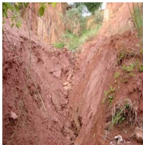
Figura 2.5 Detalhe de massa de solo recém mobilizada
