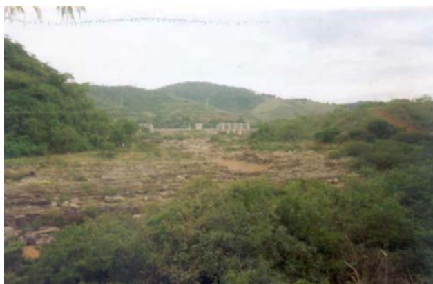
Figura13-204-Carmo - Usina Hidrelétrica Ilha dos Pombos
