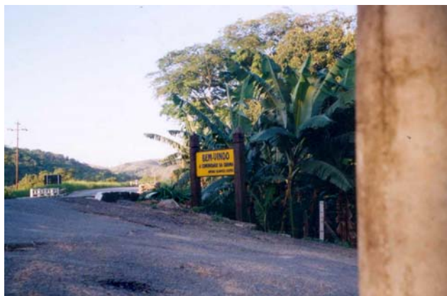
Figura 13-75 Acesso – Ponte Sobre o Córrego da Grama-BR-393
