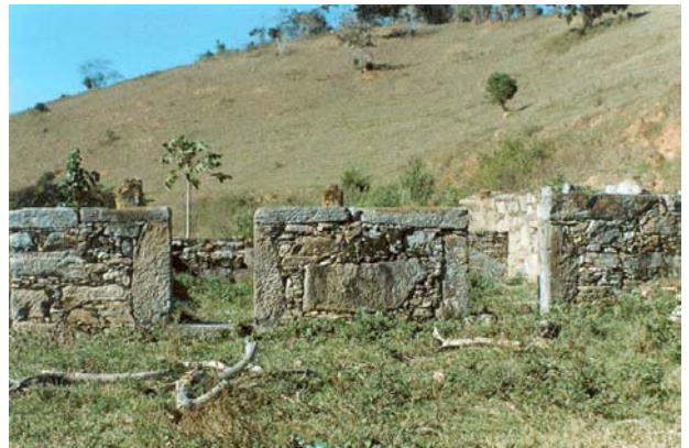
Figura 12-45 Muro de pedras nos fundos da sede da Fazenda
