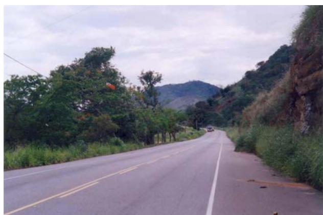
Figura 4-1 BR-393 - Trecho entre Três Rio e Sapucaia
