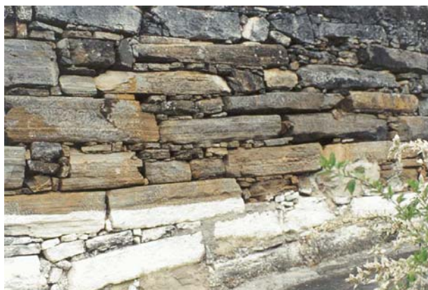
Figura 12-31 Detalhe do muro de pedra do pátio de secar café
