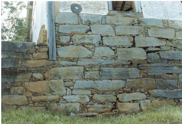
Figura 12-42 Muro da senzala da Fazenda Paraíso
