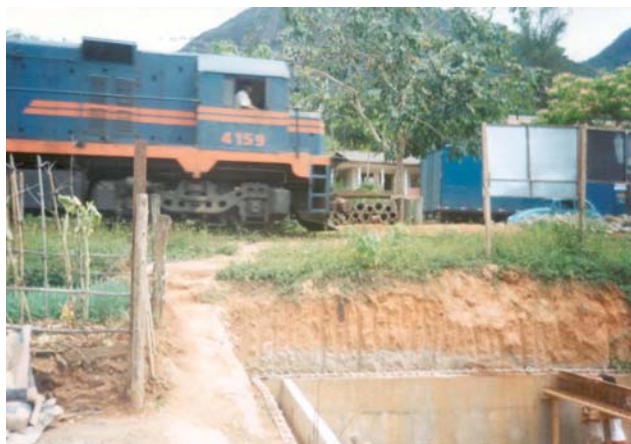
Figura 13-48 Sapucaia - Estação de tratamento de esgoto do bairro São João
