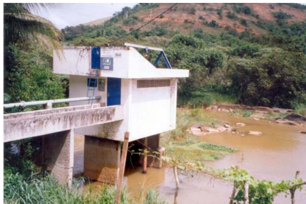
Figura 4-14 Captação – Rio Paraíba do Sul
