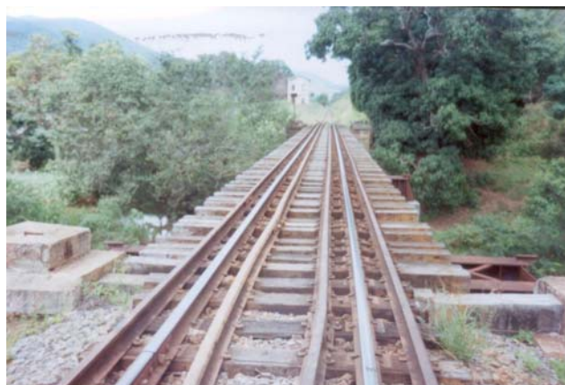
Figura 13-144 Além Paraíba - Região da Barra do Peixe - Ruínas da Estação de Simplício
