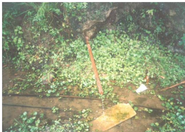
Figura 13-102 Sapucaia - Captação de água em Anta
