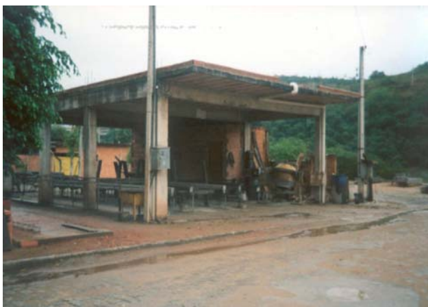
Figura 13-9 Sapucaia - Fábrica de Postes no Bairro Metrama
