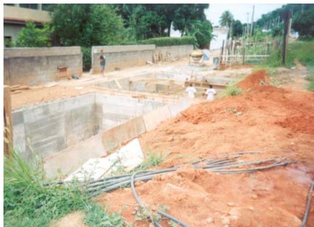
Figura 13-49 Sapucaia - Estação de tratamento de esgoto do bairro São João
