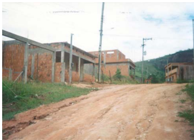
Figura 13-26 Sapucaia - Distrito de Anta- Loteamento Boa Vista
