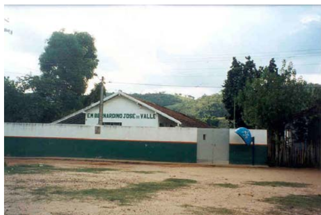
Figura 13-120 Três Rios - E.M. Bernardino José do Valle - Cerâmica Porto Velho - Região do Grama
