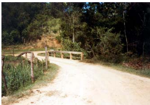
Figura 13-166 Chiador - Região do Abrigo – Ponte sobre o córrego Tocaia
