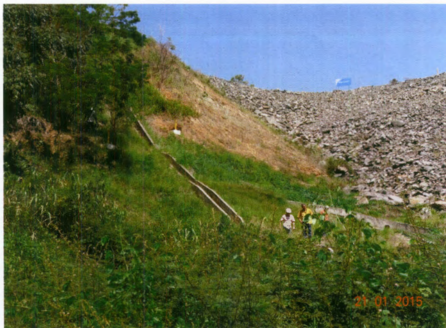
Foto 1: Dique Louriçal 1 – Vista geral da ombreira direita.
