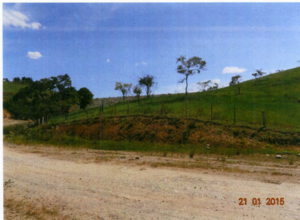
Foto 5: Dique Norte – Vista geral da região à jusante próximo a estrada de acesso.
