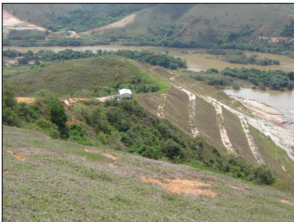
Foto 20: Aspecto do Trecho 9, localizado na Área Industrial da Usina de Anta.
