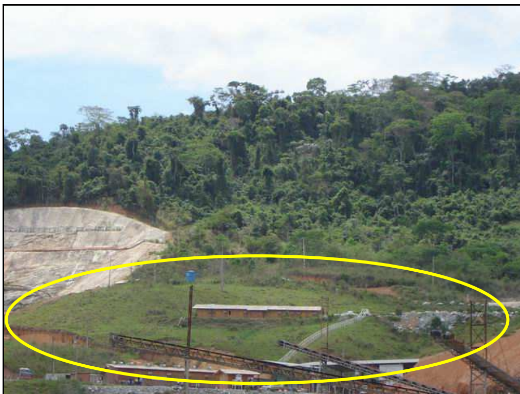
Foto 41: Detalhe da região do trecho 23.
