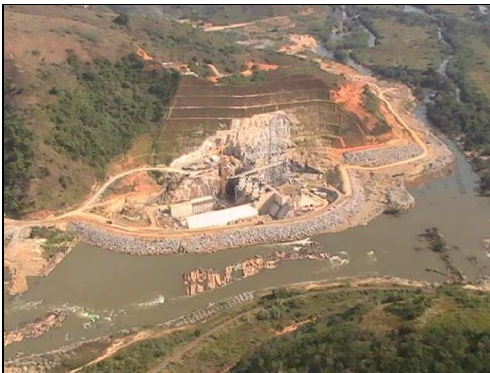
Foto 21: Visão da Área Industrial da Usina de Anta.
