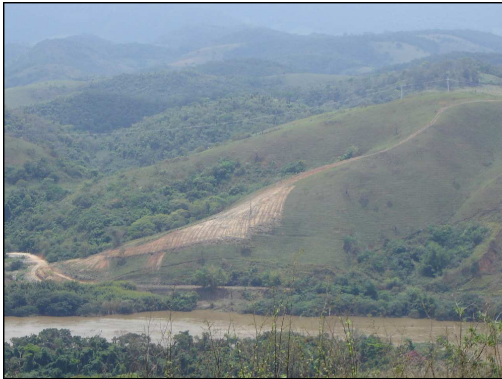
Foto 22: Parte do Trecho 10, localizado entre a barragem de Anta e o córrego Macuco, onde haverá redução da APP em função da FCA.
